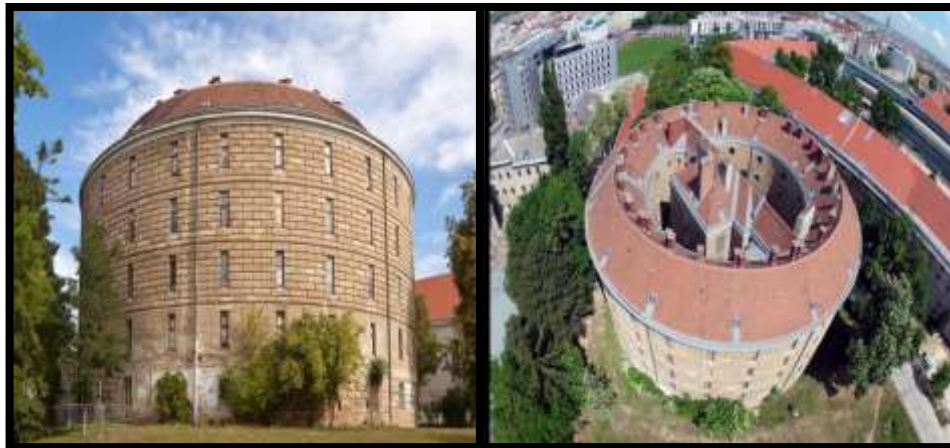
Figura 28: Hospital Torre de Los Locos
