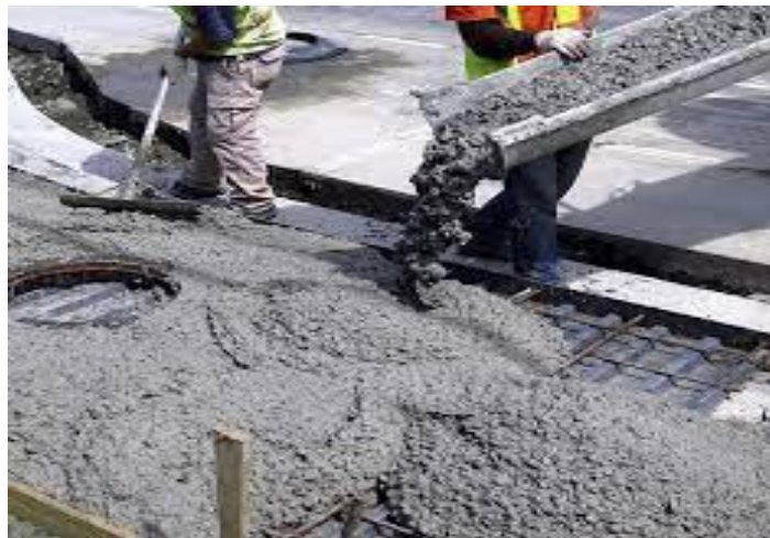
Figura 1. Vaciado de concreto
