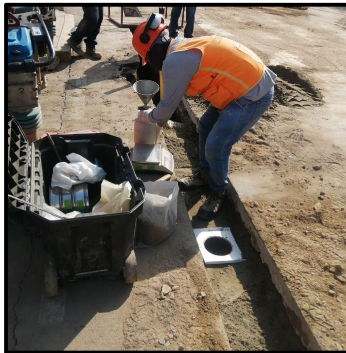
Figura 14. Ensayo de compactación de suelo. Fuente: El autor.
