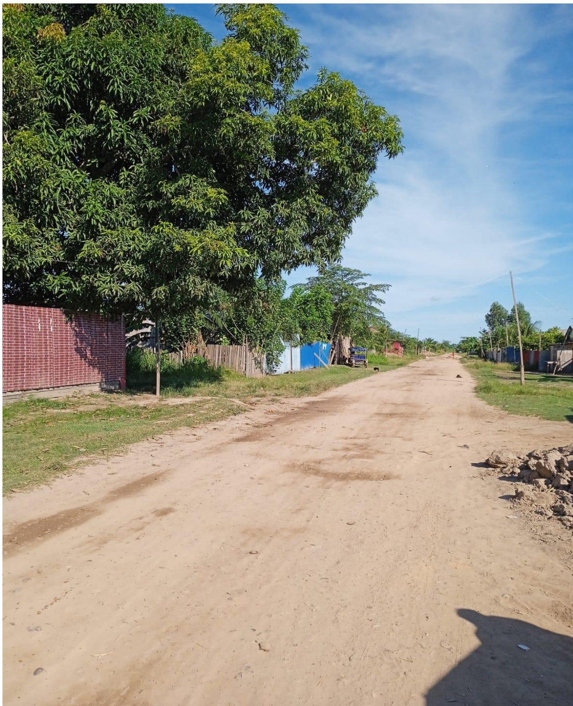
Fotos 3: Avenida principal del Caserío.
