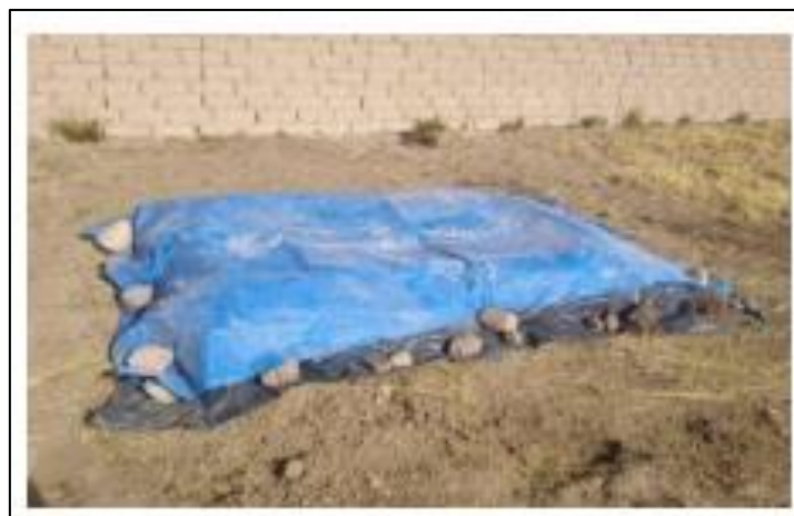
Figura 11. Secado y protección del adobe
