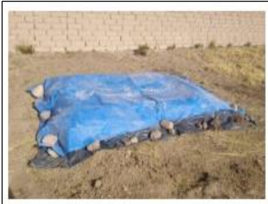
Secado y protección del adobe
