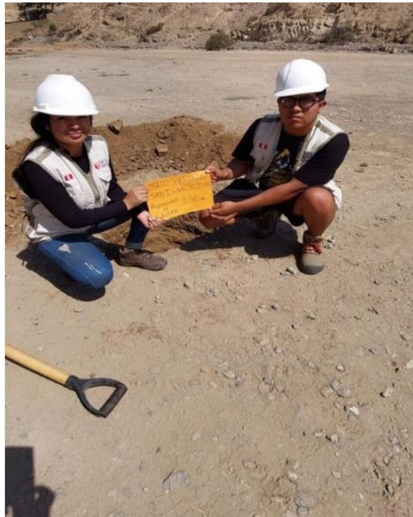
Imagen 1: Punto Inicial de excavación de calicatas
