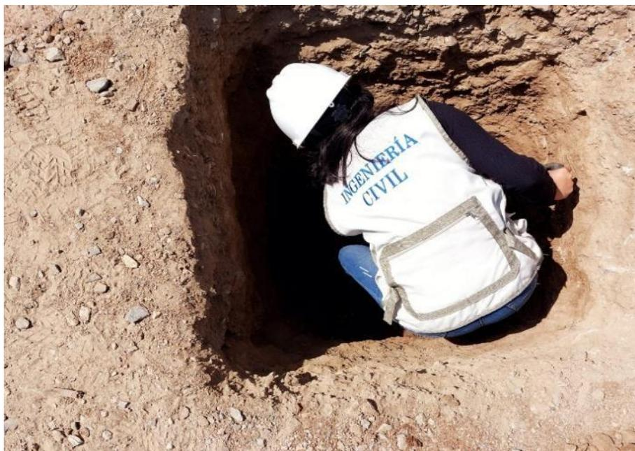
Imagen 5: Excavación de Calicata 06
