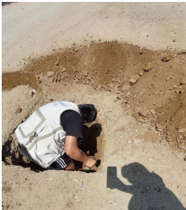
Imagen 7: Excavación de Calicata 10
