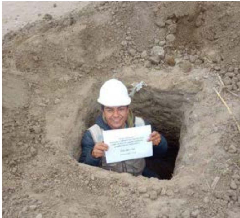
Imagen 25: Tesista comprobando profundidad de Calicata.
