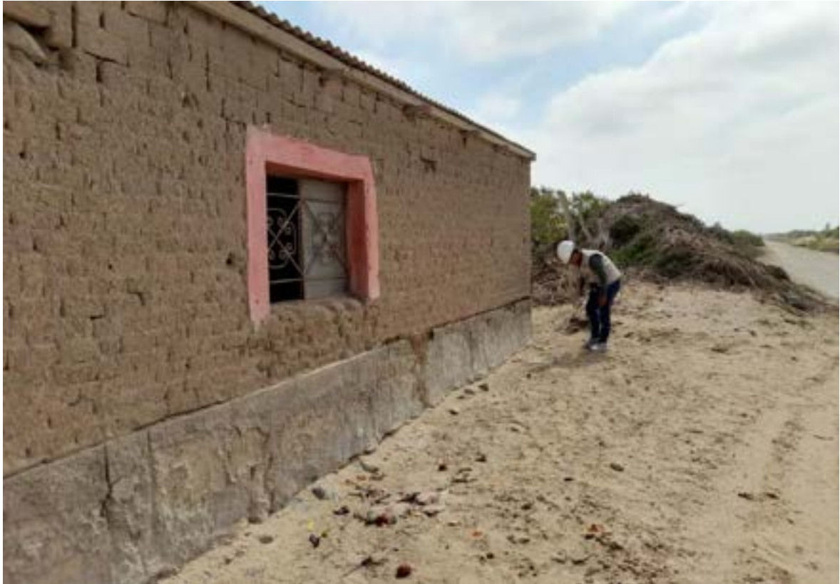
Imagen 93: Tesista realizando mediciones para el cálculo de Afectaciones Prediales
