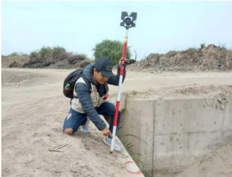
Imagen 19: Personal de topografía señalando un posible BM.
