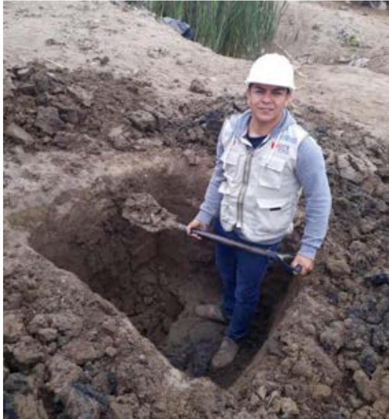
Imagen 91: Tesista realizando calicata para Extracción de Muestra de Suelo
