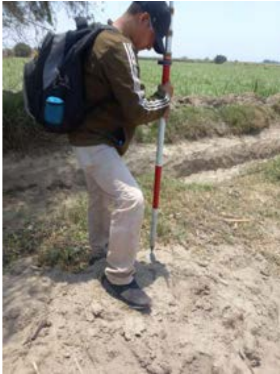
Imagen 18: Personal de Topografía sosteniendo el Prisma para las mediciones
