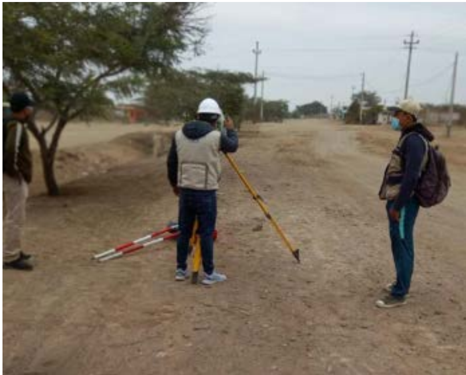
Imagen 17: Personal de Topografía sosteniendo el Prisma para las mediciones
