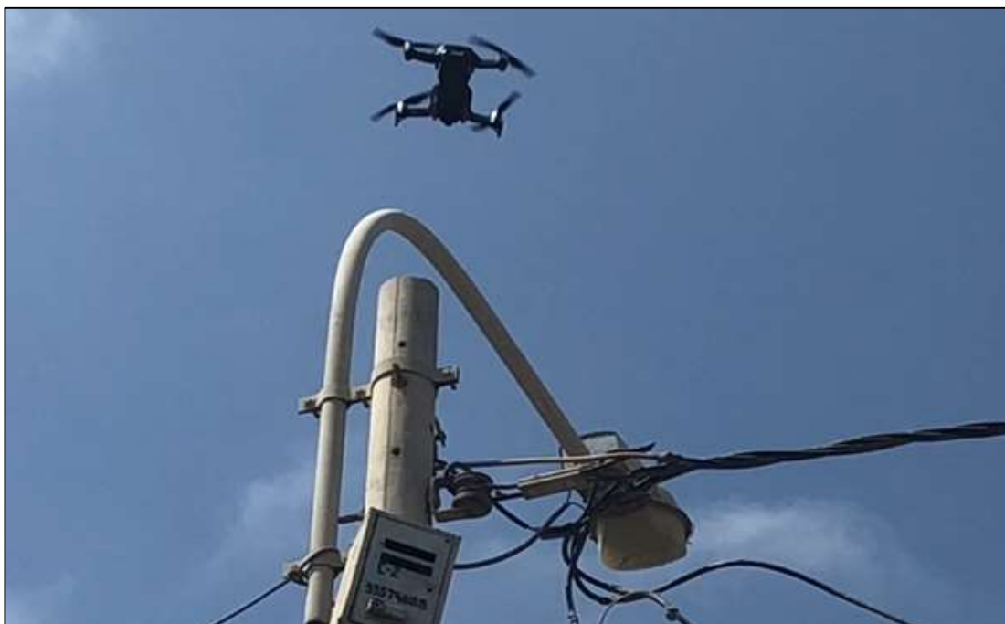
Figura 01. Prueba piloto de registro de medidor cerrado Fuente: Elaboración propia
