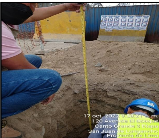
Medición de las calicatas
