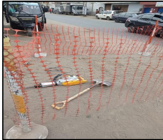
Inicio de la excavación de las calicatas
