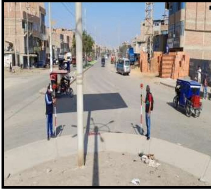
Foto N° 03.-Vista fotográfica de la ubicación de la porta prisma, en la avenida agricultura km 0+0.00
