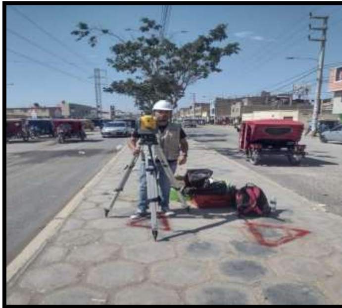
Foto 1.- Vista fotográfica de la zona de trabajo avenida agricultura.
