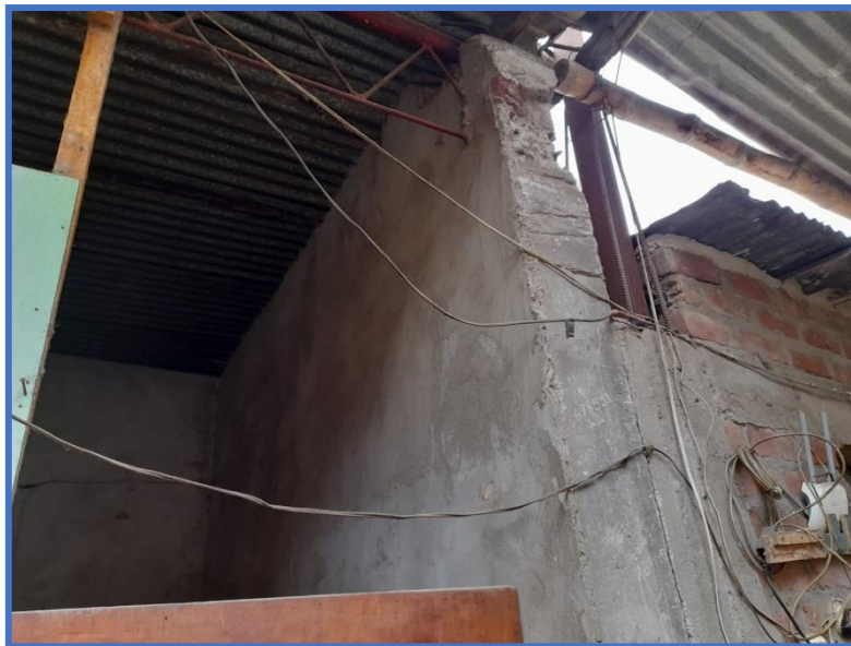
Estructura expuesta a la intemperie
