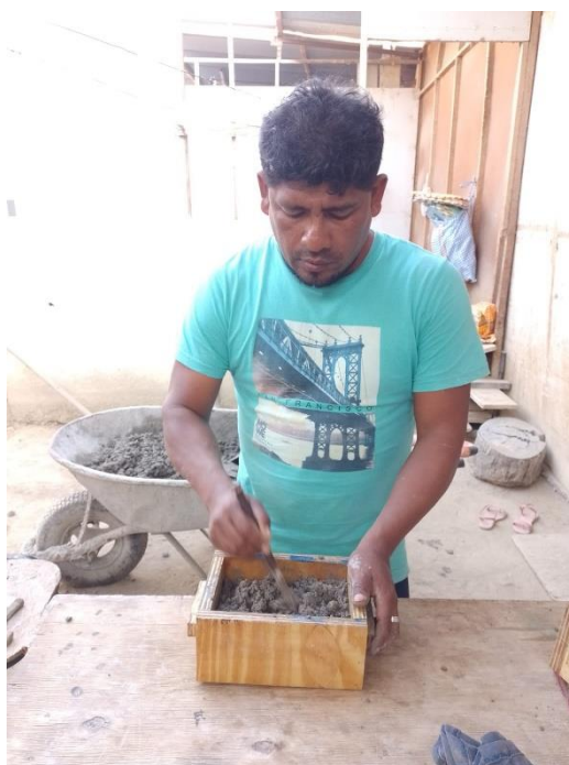
Fabricación de ladrillos
