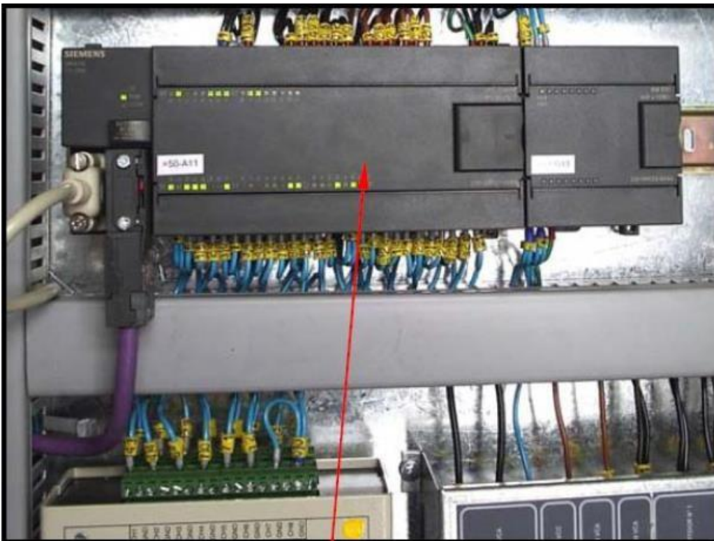
Anexo 33. panel prioritario, es el que se encarga de hacer recircular el gas del compresor a los cilindros..
