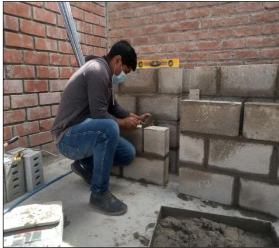
Figura 4. Elaboración de muretes de ladrillo de concreto - Chávez (2020)
