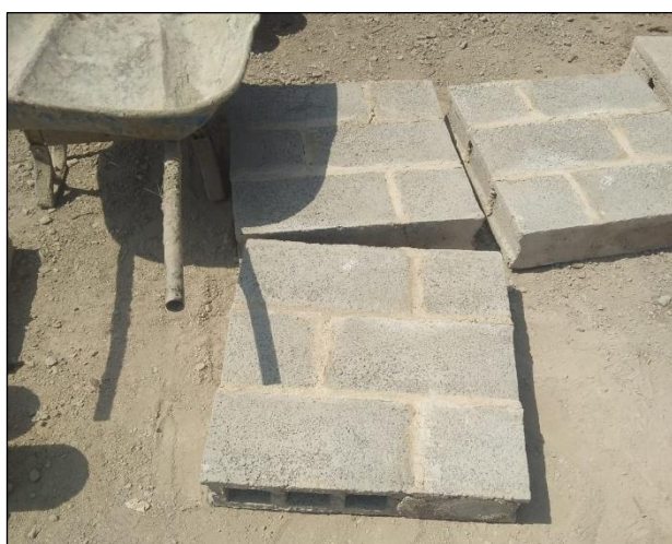
Figura 1. Muros de ladrillo de concreto
