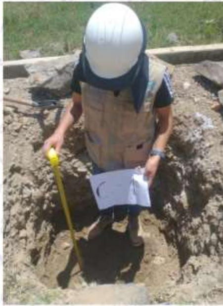
**Foto N°01:** Vista de la C-01, presencia de Limo Arenoso (ML) de consistencia compacta, húmeda y de color beige claro de 0.00 a 1.50m.
