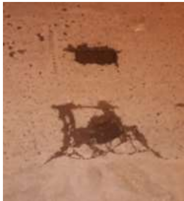
Figura 13: Evaluación de la falla tipo huecos.
