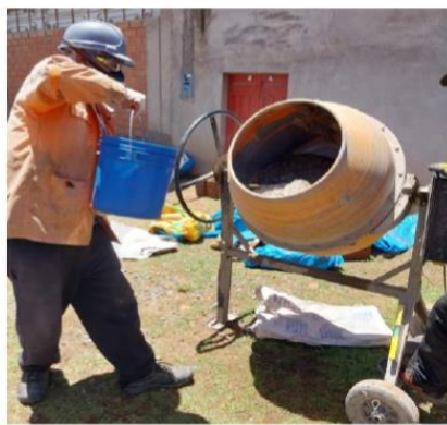
Foto N°21. Mezclado de los componentes del concreto.
