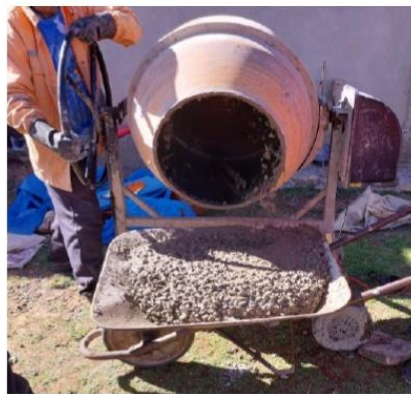
Foto N°22. Vaciado de la mezcla de concreto en carretilla.
