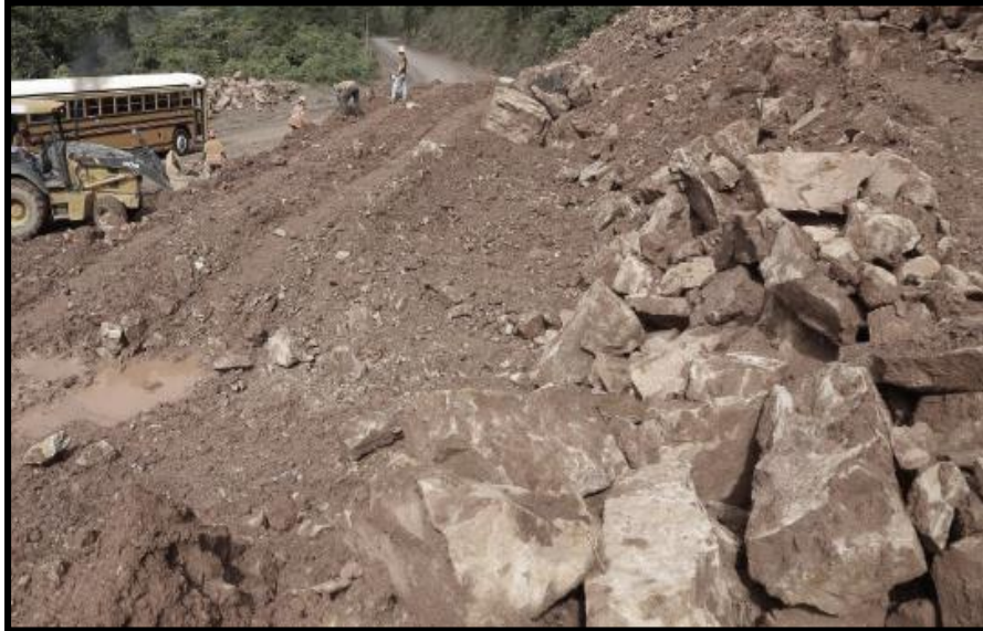
FIGURA N° 36 BOTADERO AUTORIZADO PARA LA DISPOSICIÓN DEL MATERIAL EXCEDENTE DE LA OBRA
