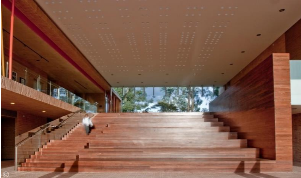
Figura 8. Acceso principal del Colegio Los Nogales – Colombia
