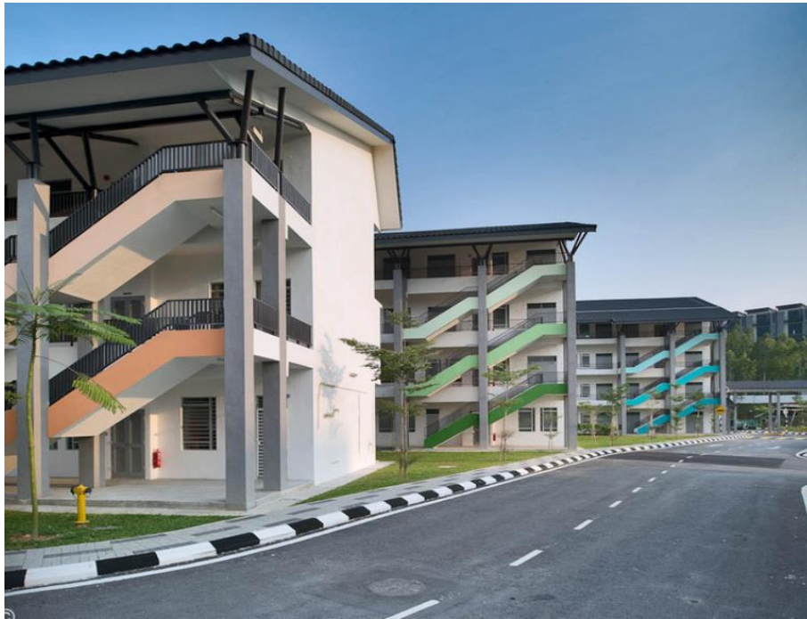
Figura 12. Fachada Este de la Escuela Desa Mahkota
