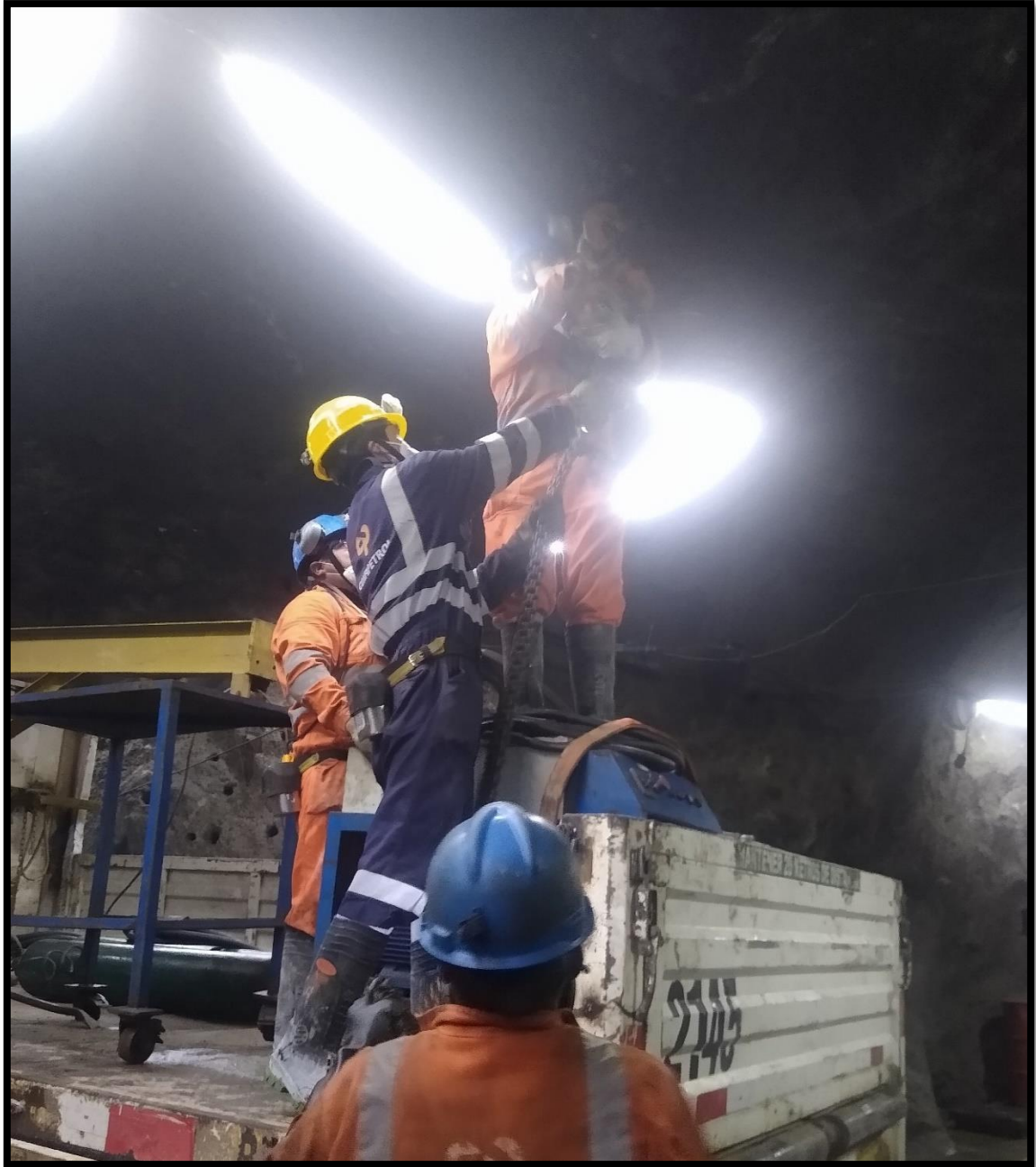
Figura 14. Carga de máquina mandrinadora en camión liviano en socavón
