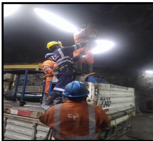
Figura 11. Instalación de tecele manual para descarga de maquina en socavón.
