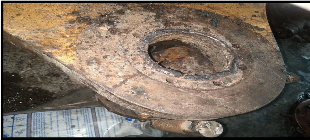
Figura 6. Alojamiento rellenado con soldadura
