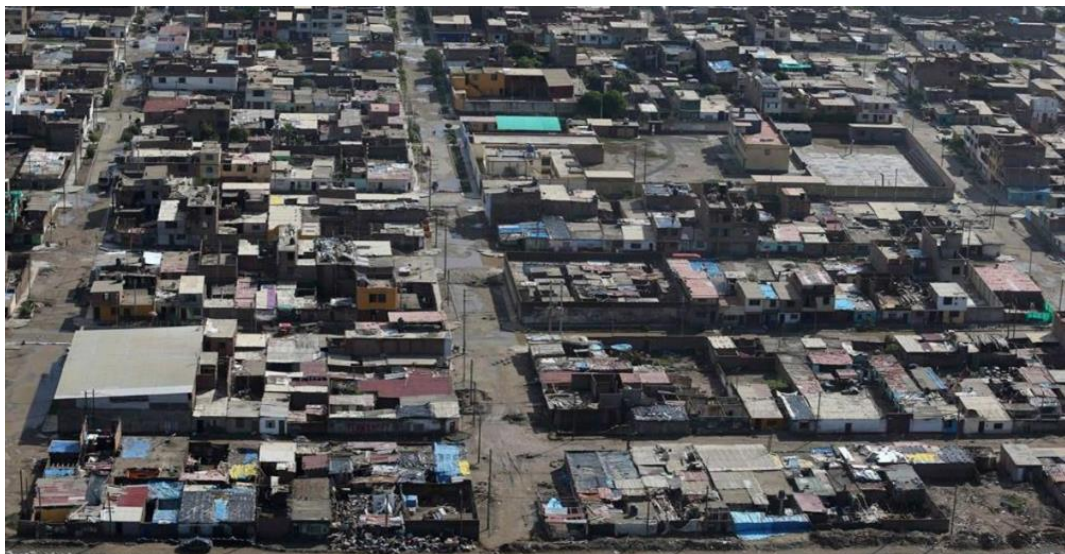
Foto N° 4.. Vista del sector Rio Seco inundado por la Quebrada de San Ildefonso. (Fuente: www.rpp.com.pe/noticias )
