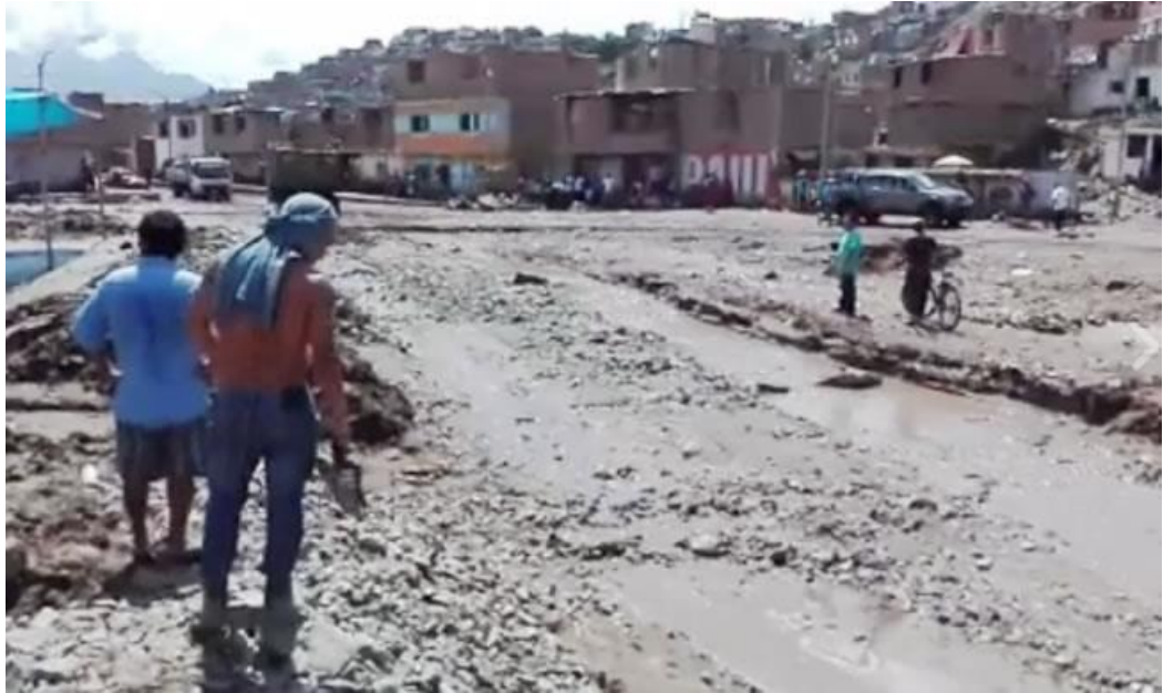
Foto N°3. Estado de viviendas y calles en el sector Rio Seco de El Porvenir después de las inundaciones producidas por el Fenómeno El Niño, marzo 2017. Fuente: Google.
