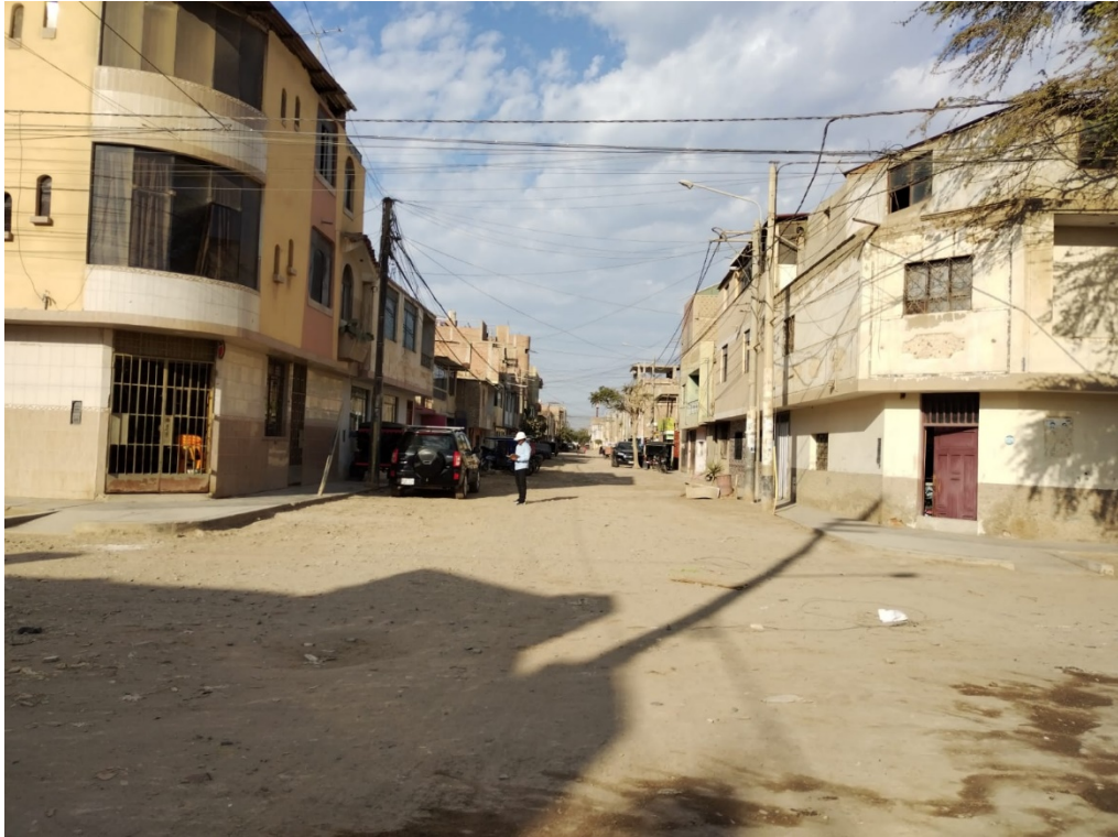
Figura 11-12. Cruces de boca calles, sin ningún tipo de señalización.
