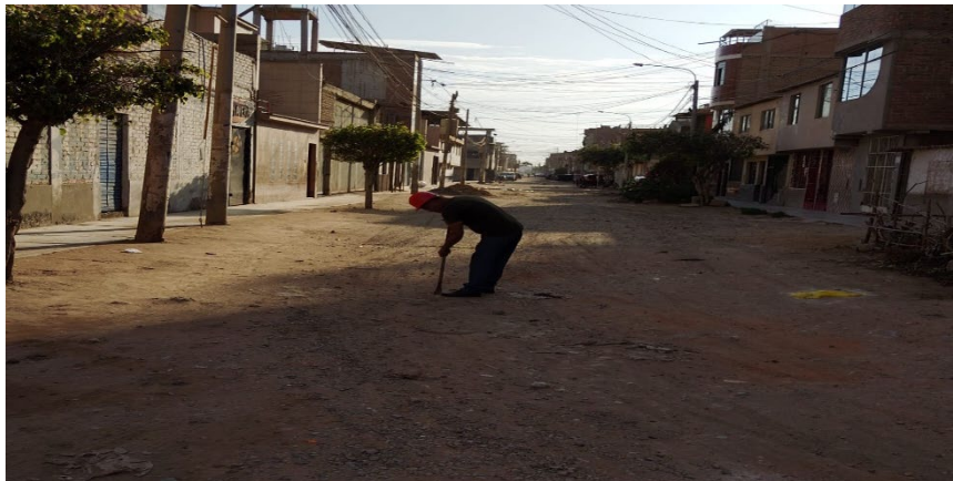
Figura 6-7. Limpieza y marcado de área para excavación de calicata.
