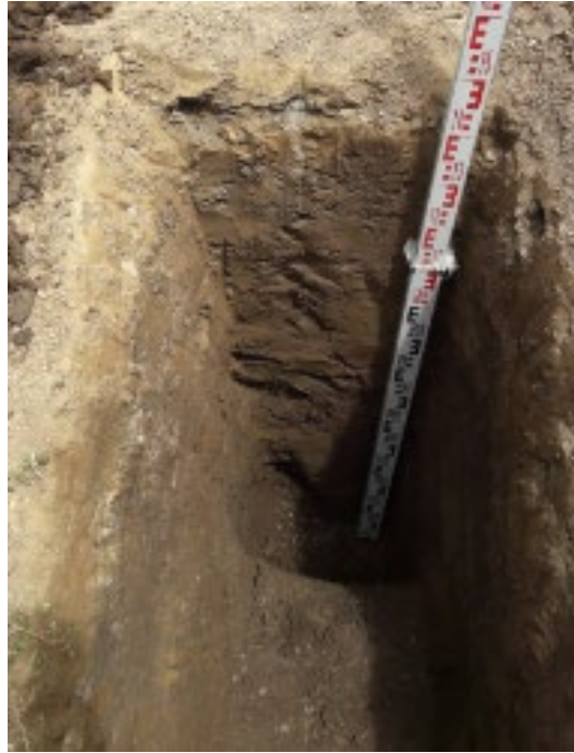
Figura 8-9. Excavación de calicata C1 calle Cajamarca Norte.
