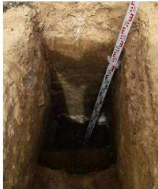
Figura 10-11. Excavación de calicata C6 calle Arequipa Norte.
