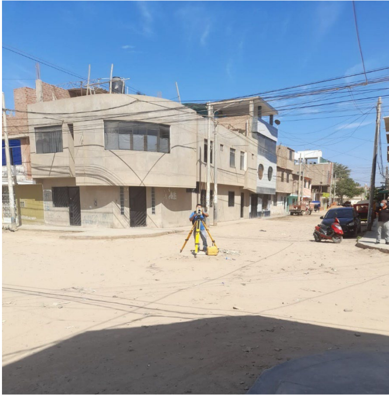
Figura 3. Levantamiento topográfico de vía.
