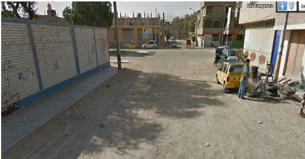
Figura 7. Falta de señalización en acceso Fernando Belaunde Terry a Tungasuca.
