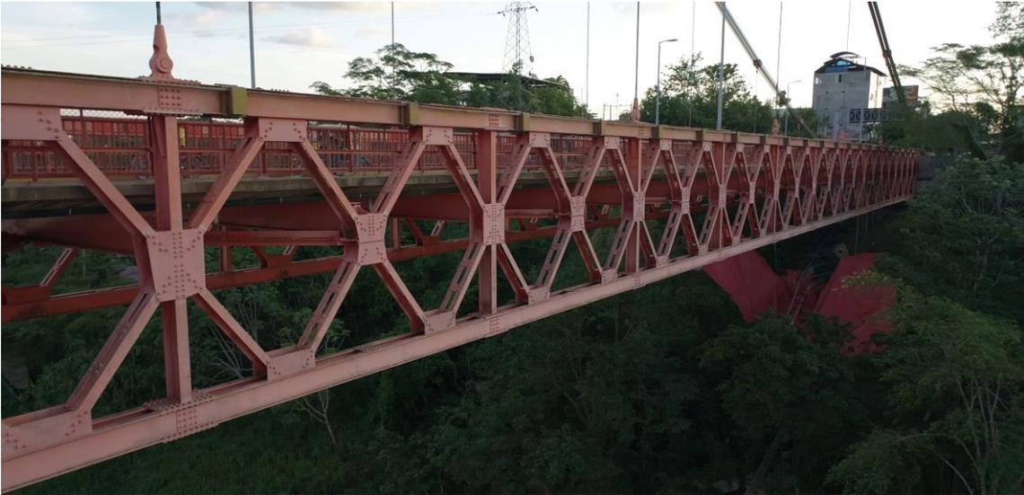
**Fig. 01.** Tramos típicos de viga de rigidez con pintura descolorida
