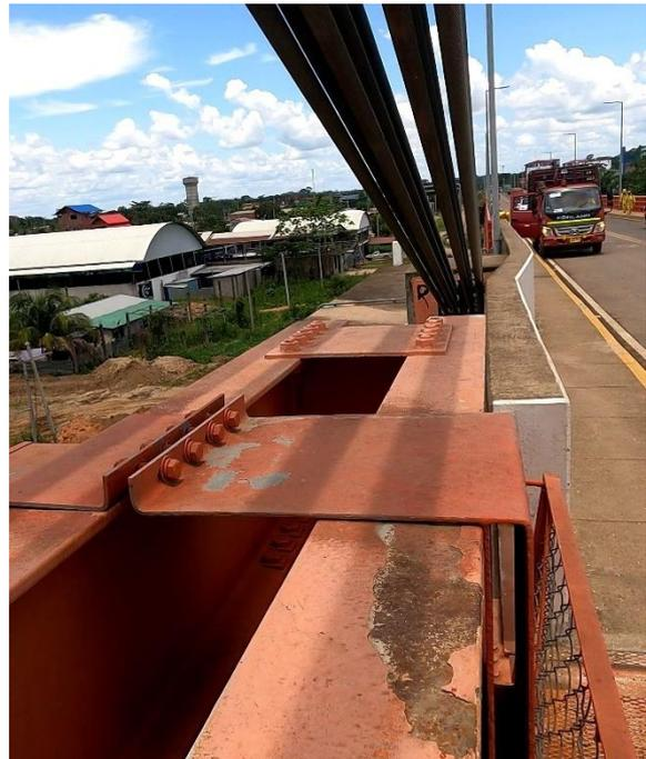
**Fig. 11** Corrosión en parte superior de Viga de Rigidez, Margen Izquierdo - Aguas Arriba, grado de corrosión 3-S, 16%. **Fuente:** Escala comparativa de los grados de oxidación y el tipo de distribución del óxido NR. ASTM D610.
