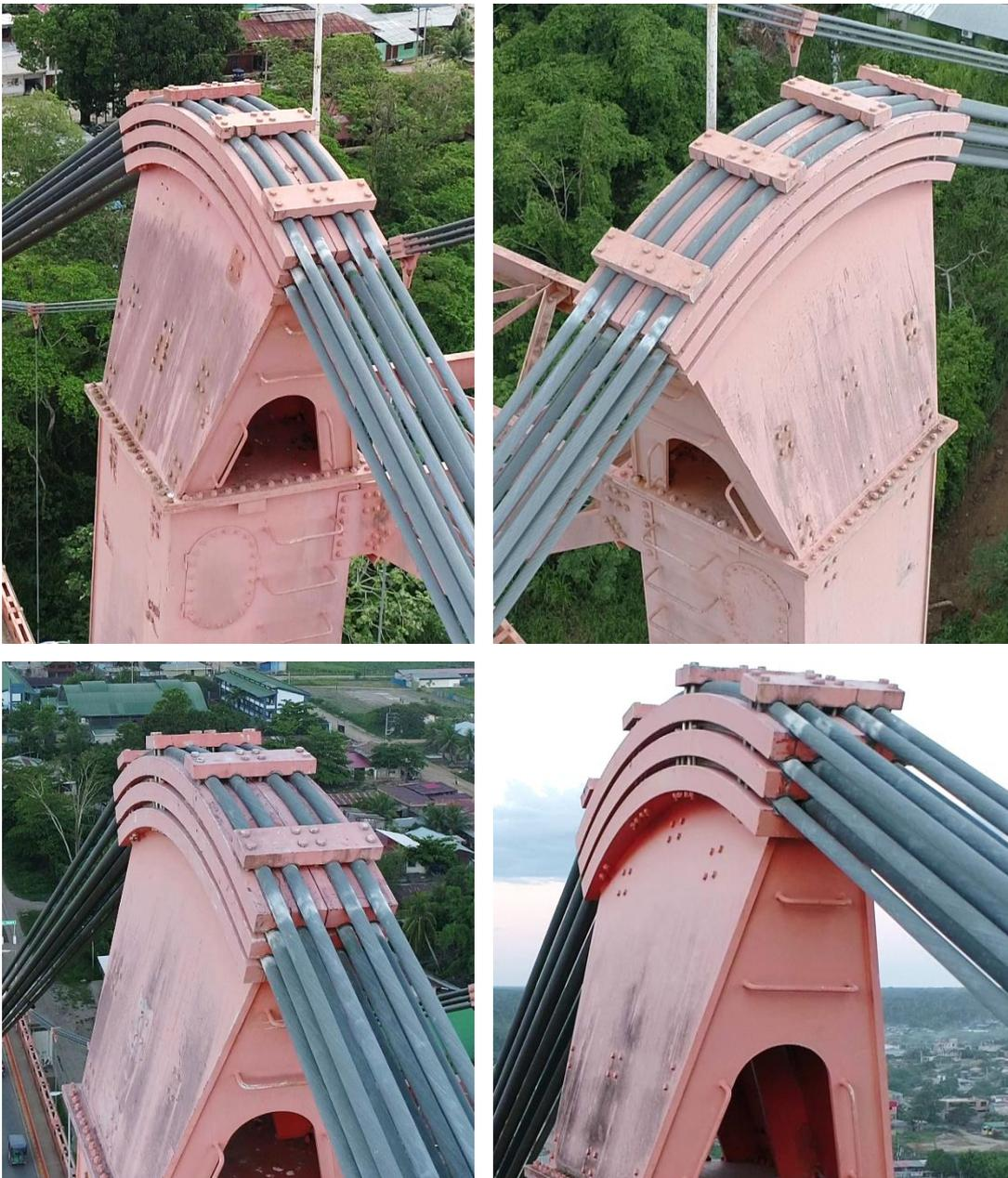
**Fig. 13.** Presencia de inicios de corrosión en los cables principales en las sillas de cambio de ambas torres. **Fuente:** Elaboración Propia.
