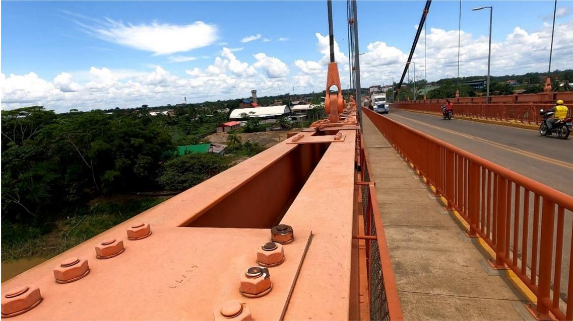
**Fig. 10.** Presencia de pérdida del recubrimiento y corrosión en pernos de las planchas superiores.
