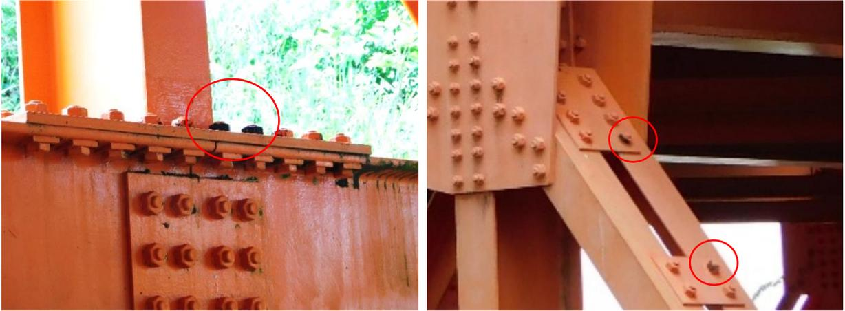
**Fig. 12.** Corrosión en fillos y pernos, grado de corrosión 6-S, 1%.
