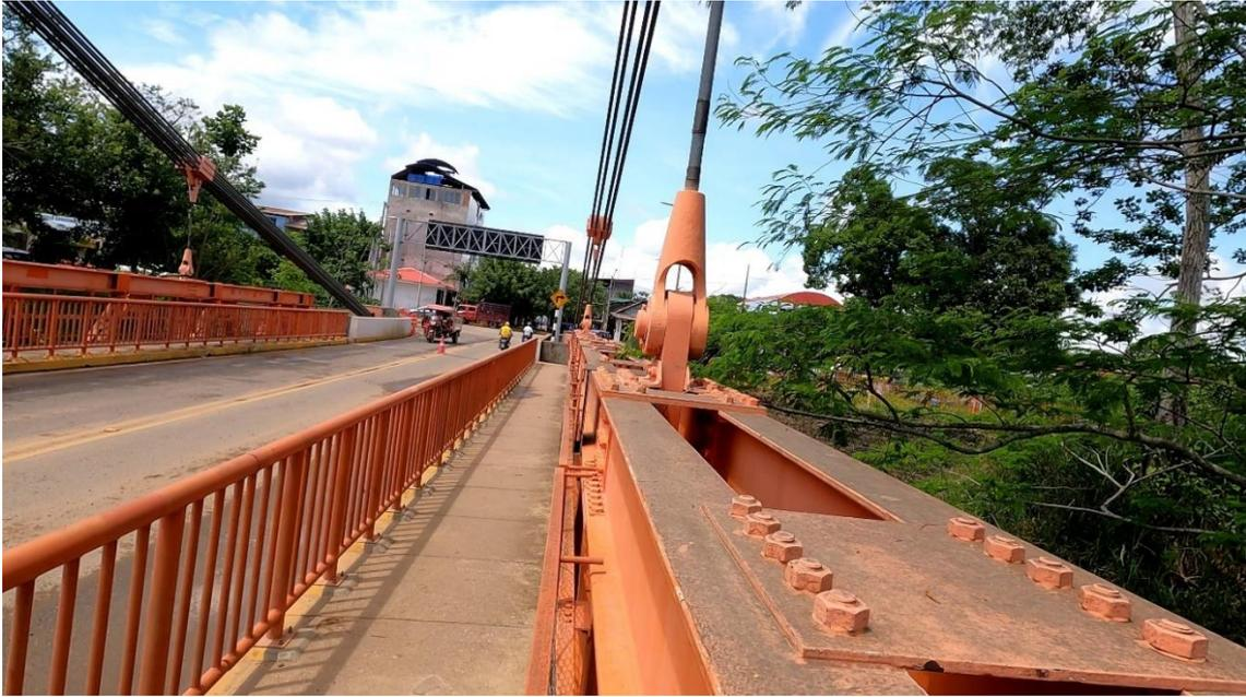
**Fig. 02.** Tramos típicos de viga de rigidez en proximidades de una de las torres
