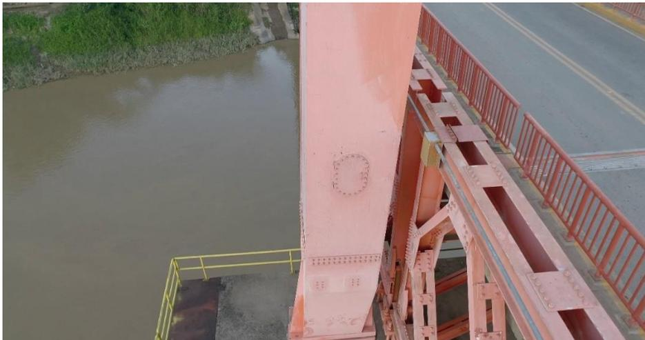
**Fig. 05.** Nótese Pérdida De Brillo Del Sistema De Recubrimiento De Protección. Fuente: Propia
