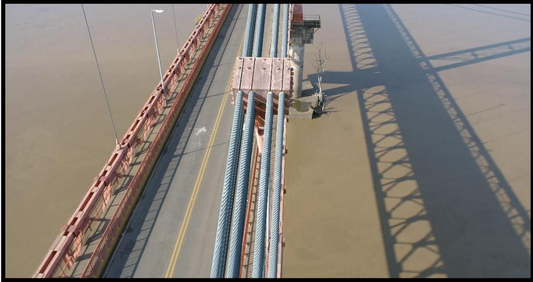
**Fig. 06.** Detalle De Una De Las Sillas De Cambio En La Zona Superior. Fuente: Propia
