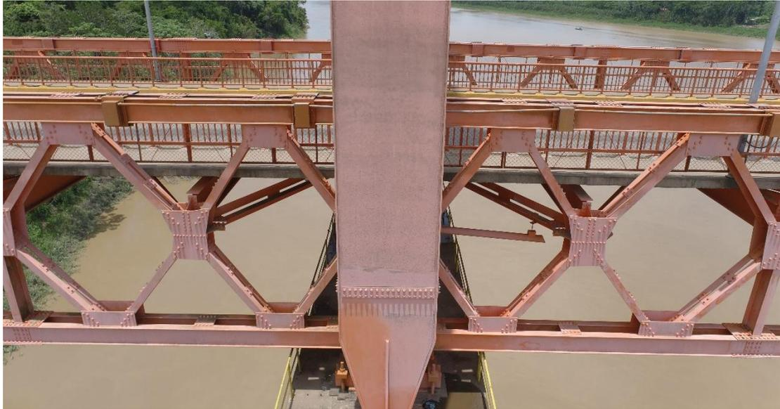
**Fig. 04.** Nótese Pérdida De Brillo De La Pintura Por Volatilización De La Capa Externa De Poliuretano.
