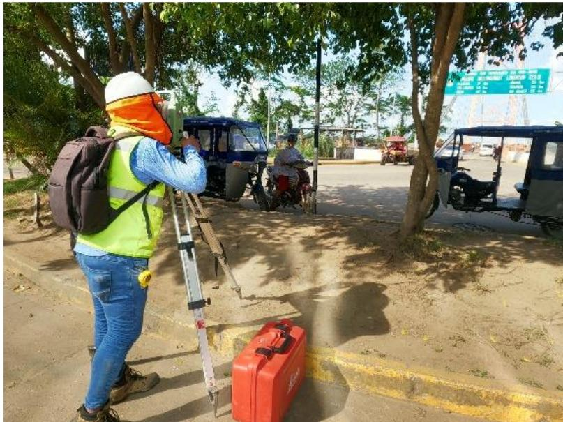
**FOTO 06:** LEVANTAMIENTO TOPOGRAFICO DEL PUENTE BILLINGHURST DESDE BOULEVART LEON VELARDE-INICO DEL PUENTE BILLINGHURST
