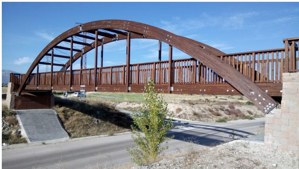
Figura 4: Puente peatonal de madera laminada con arco y 30 m de luz en Madrid.
