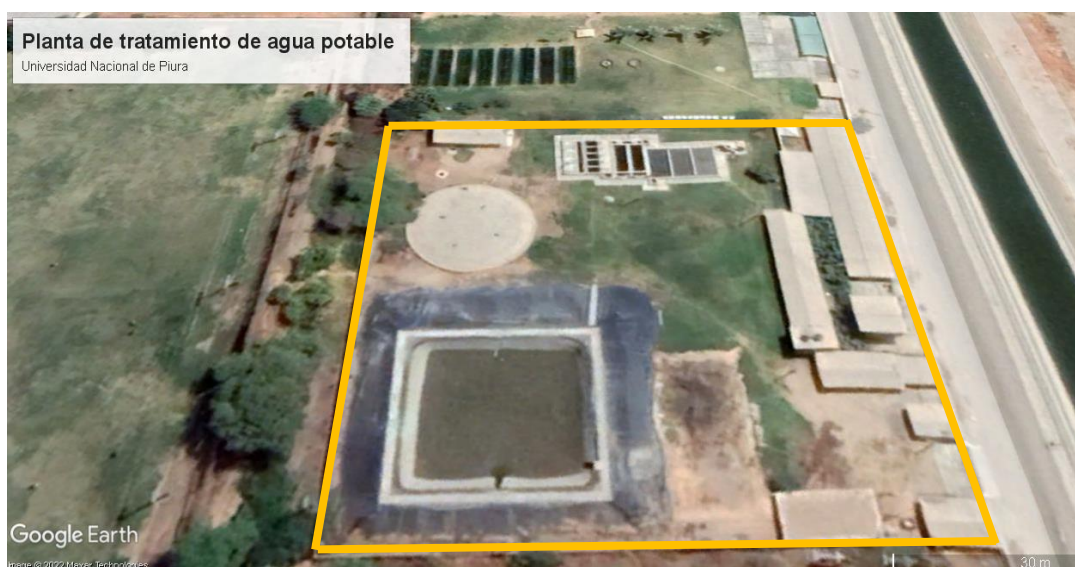
Figura 1. Planta de tratamiento de agua potable
