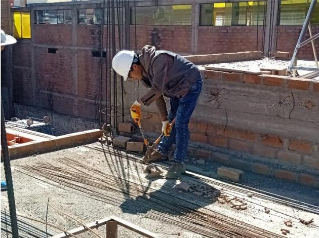
**Panel fotográfico 1:** Cortado del acero para estribo para el armado de la estructura.
