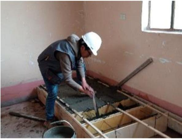
**Panel fotográfico 7:** Vaciado y compactado del concreto en vigas.
