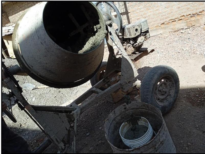
**Figura 18.** Mezclado del concreto.
