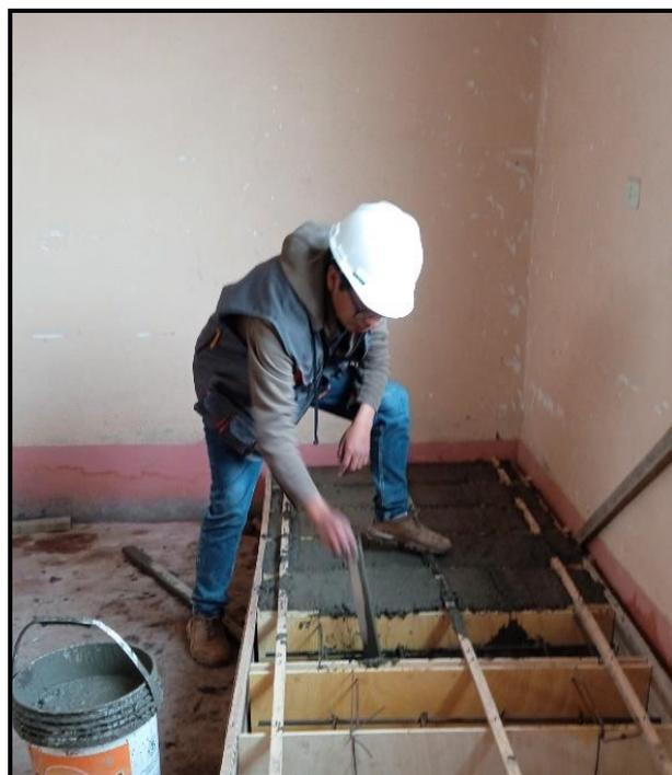
**Figura 19.** Vaciado de concreto en vigas.
