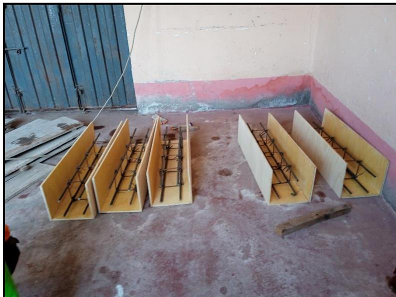
**Figura 17.** Estructura de acero y encofrado.
