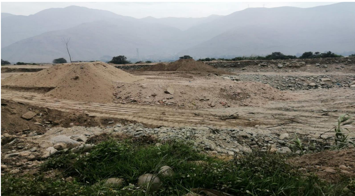
Foto 16: Evidencia de desmonte
