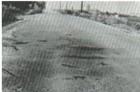
Figura 16. Desplazamiento de severidad media
