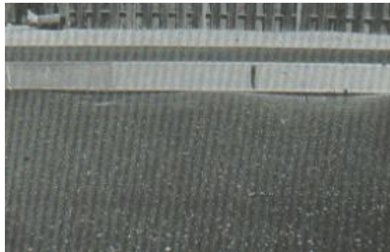
Figura 5. Corrugación de severidad media
