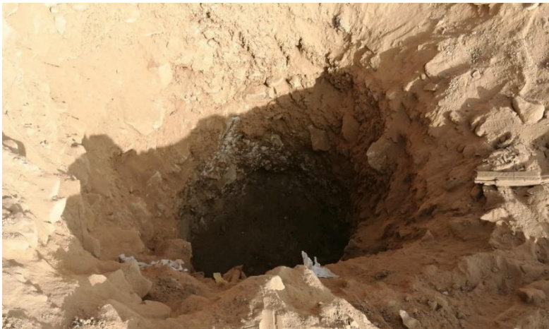
Figura 7. Calicata C-2. Fuente: Fotografía propia
