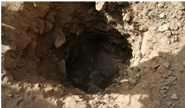
Figura 8. Calicata C-3. Fuente: Fotografía propia
