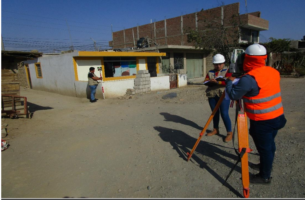
Fig. Nº 05.- LEVANTAMIENTO TOPOGRAFICO TRAMO PROGRESO CON CALLE 6 DEL CP. CHICAMA PARA EL PAVIMENTO DEL DISTRITO CHICAMA.
