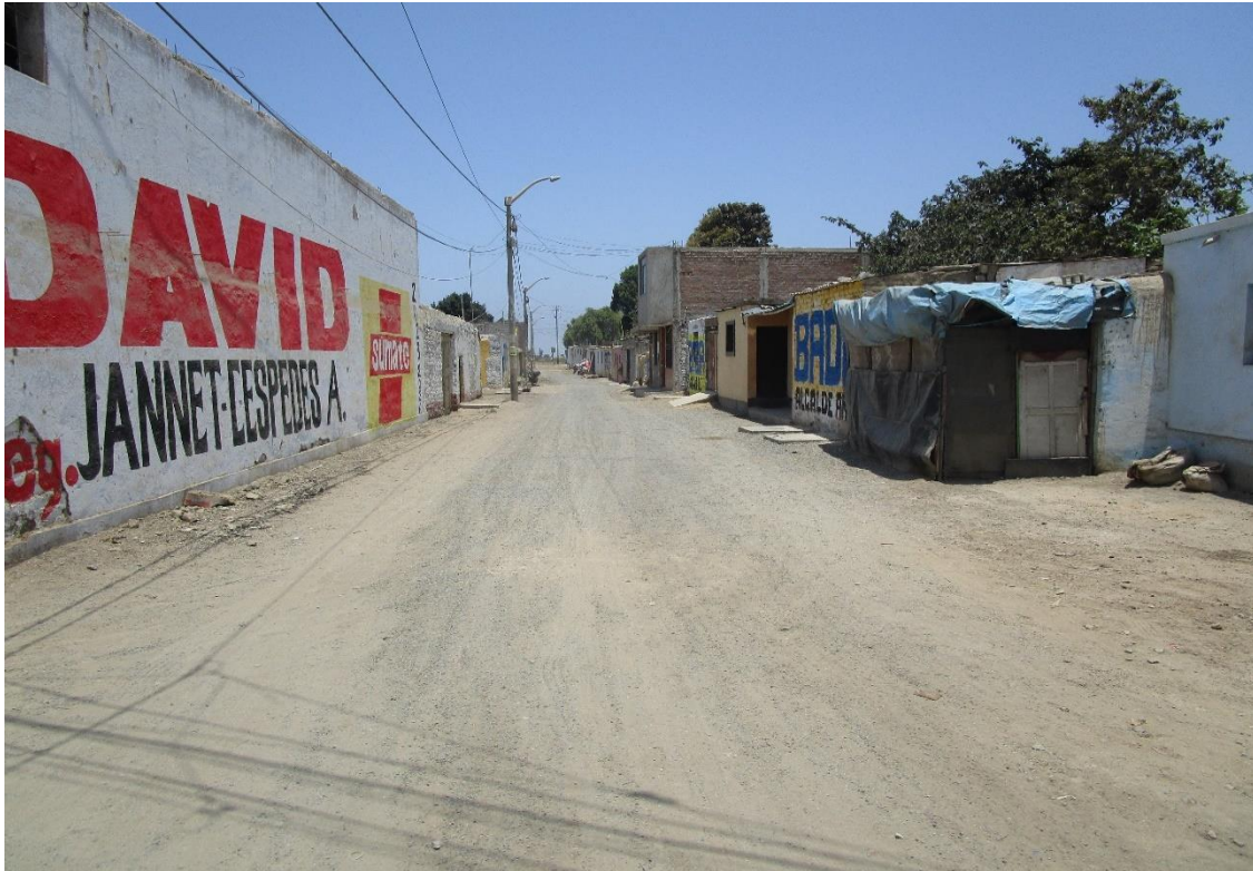
Imagen N° 9: Presencia de estructuras que no son seguras ante efectos de sismos
