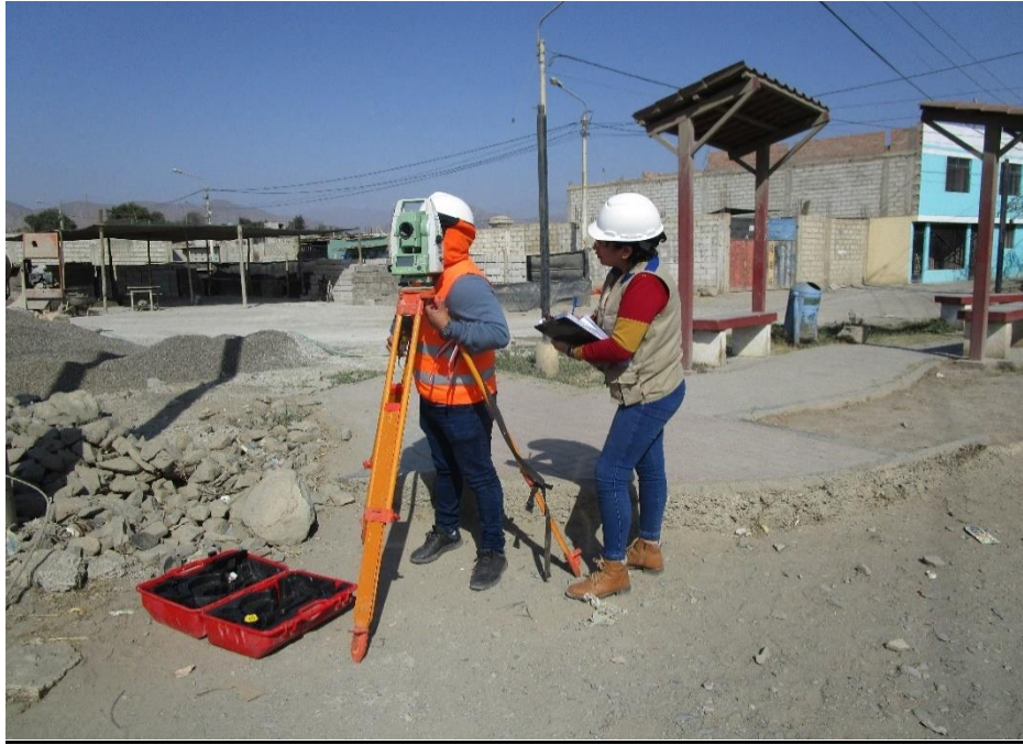
Fig. Nº 03.- LEVANTAMIENTO TOPOGRAFICO TRAMO PROGRESO DEL CP. CHICAMA PARA EL PAVIMENTO DEL DISTRITO CHICAMA.
