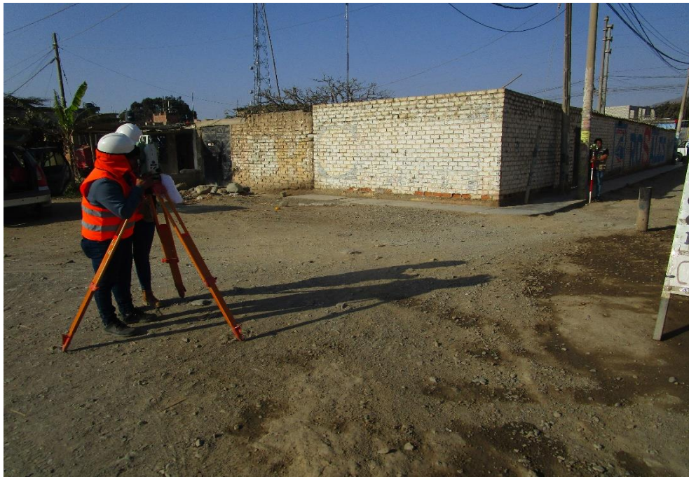
Fig. Nº 08.- LEVANTAMIENTO TOPOGRAFICO TRAMO PROGRESO CON CALLE ROSARLES DEL CP. CHICAMA PARA EL PAVIMENTO DEL DISTRITO CHICAMA.
