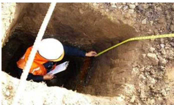
Figura 4. Proceso de exploración- Realización de calicatas Fuente: Elaboración propia.
