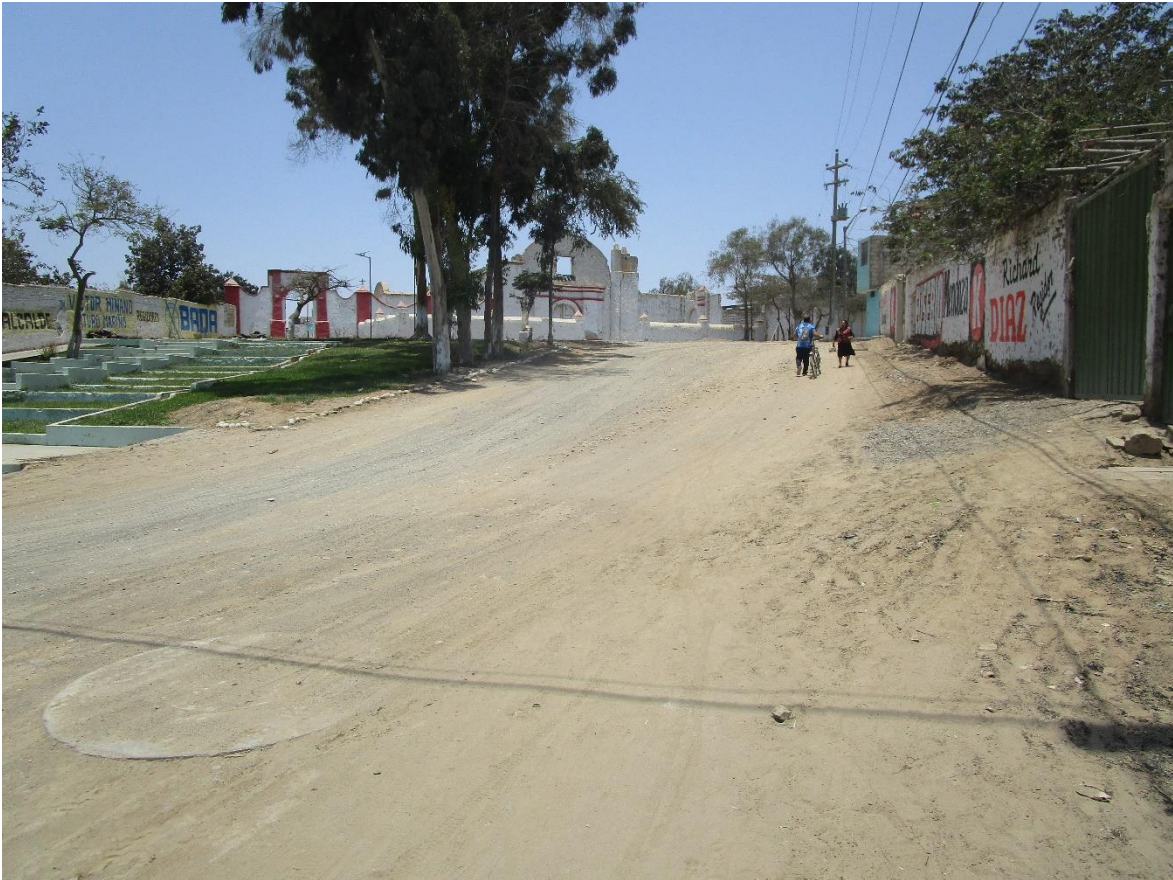
Imagen N° 8: Presencia de terreno suelto en la zona del proyecto
