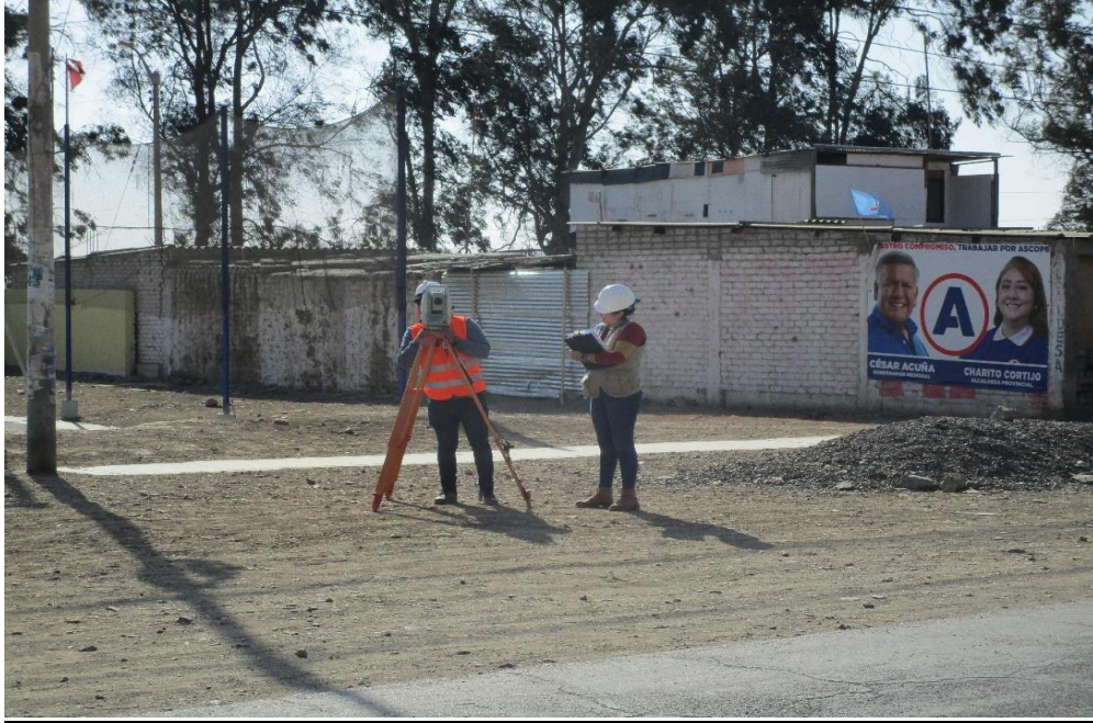
Fig. Nº 07.- LEVANTAMIENTO TOPOGRAFICO TRAMO PROGRESO DEL CP. CHICAMA PARA EL PAVIMENTO DEL DISTRITO CHICAMA.
