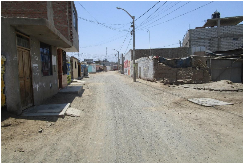
Imagen N° 10: Presencia de edificaciones que no son seguras
