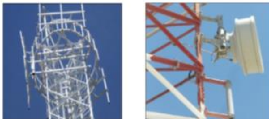
Figura 14. Montaje de cuerpos de torre
