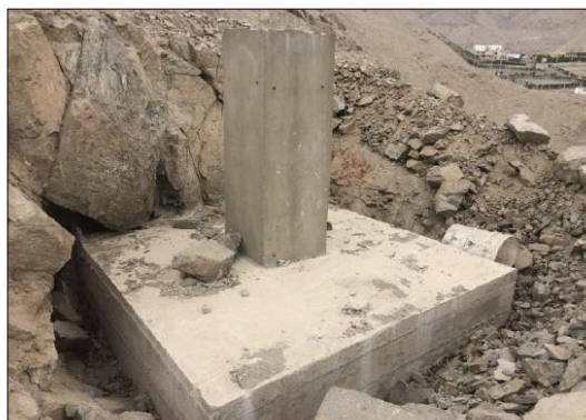
Figura 12. Instalación de la placa base
