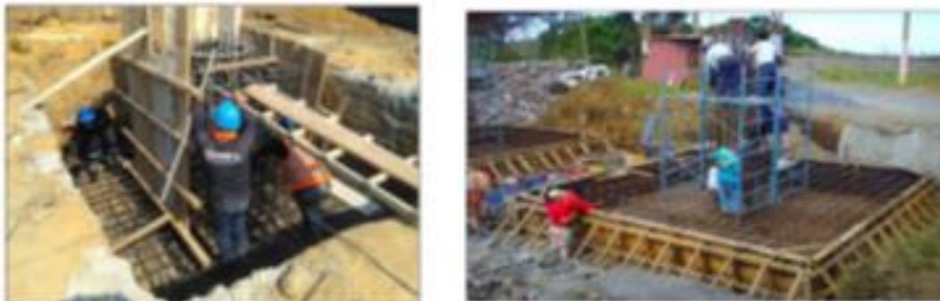
Figura 13. Montaje de la placa base
