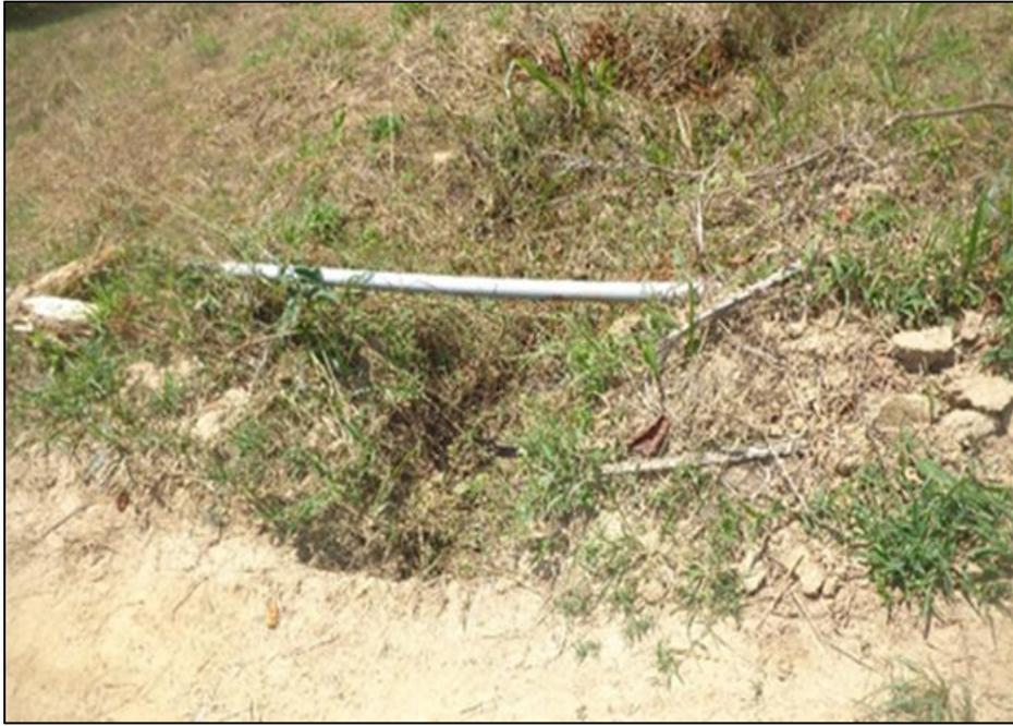
Foto N° 5: Línea de Conducción en malas condiciones.
