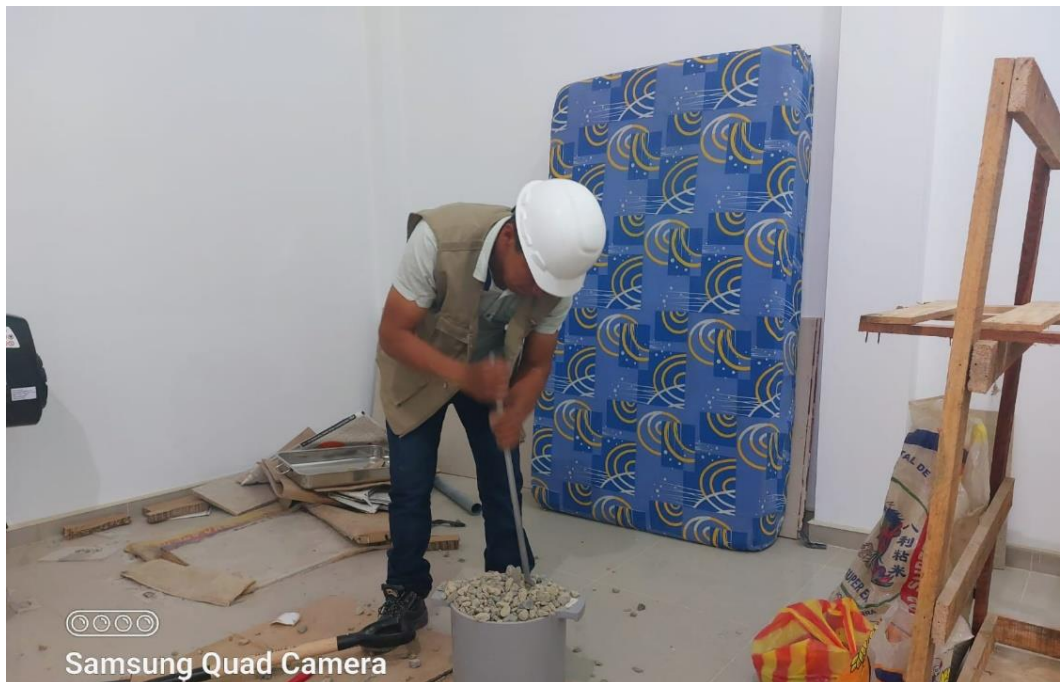
Foto 15. Apisonamiento agregado grueso
