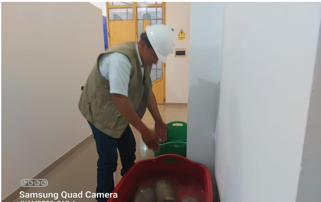
Foto 23. Curado de concreto
