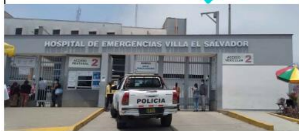
HOSPITAL DE EMERGENCIA VILLA EL SALVADOR
