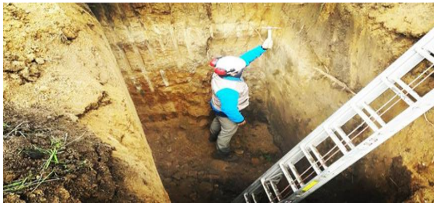
Figura 3. Proceso de exploración – Calicata.
