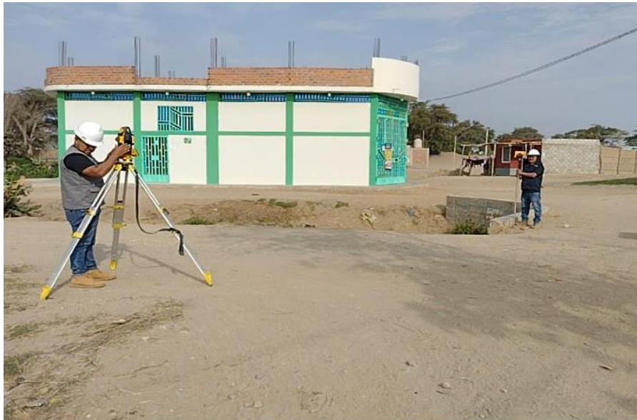
Foto 2: Levantamiento topográfico
