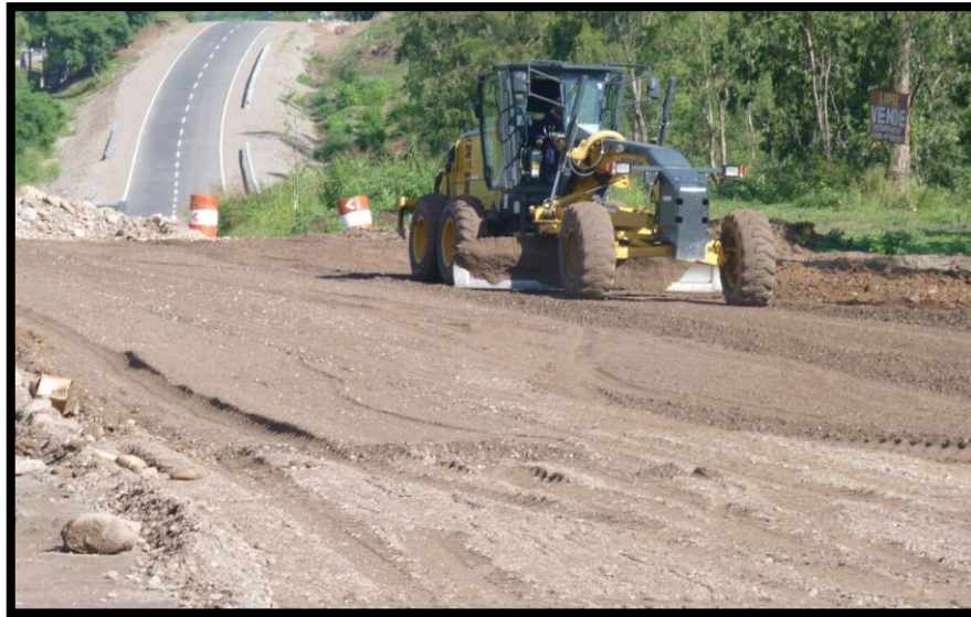
Figura 7 Preparación de subrasante
