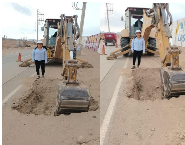
Figura 5. Excavación de calicata con maquinaria
