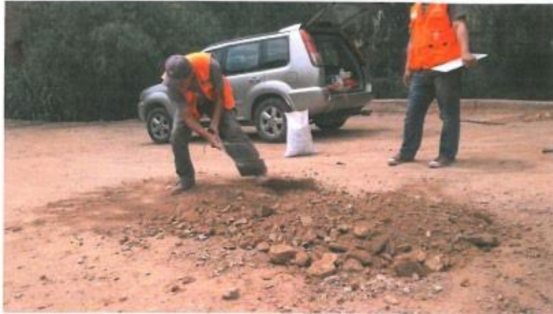
Foto N° 01. Calicata Jr Brancacho, Excavación de Calicata.
