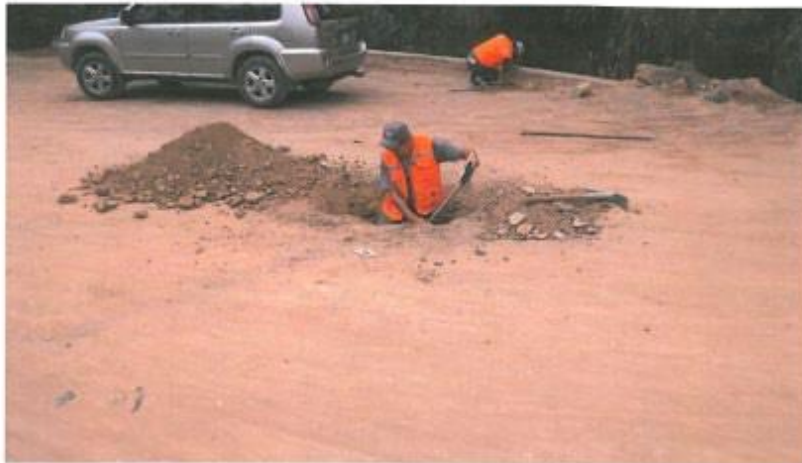
Foto N° 02. Calicata Jr Brancacho,, Excavación de Calicata.
