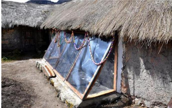
**Figura 8** Pared caliente (*muro trombe*)
