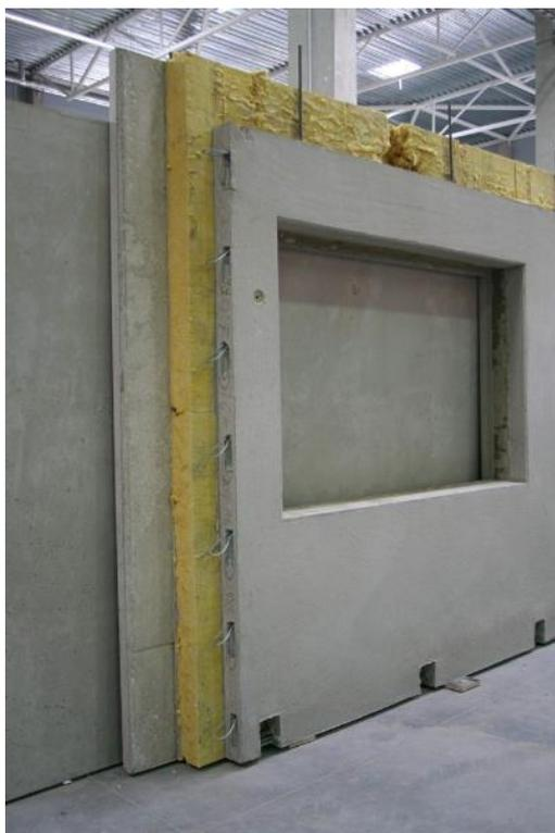
**Figura 2** Muro tipo Sandwich
