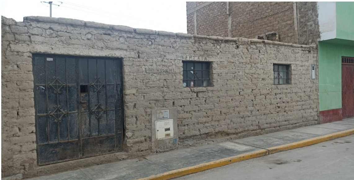
Fotografía tapa de medidor de agua
