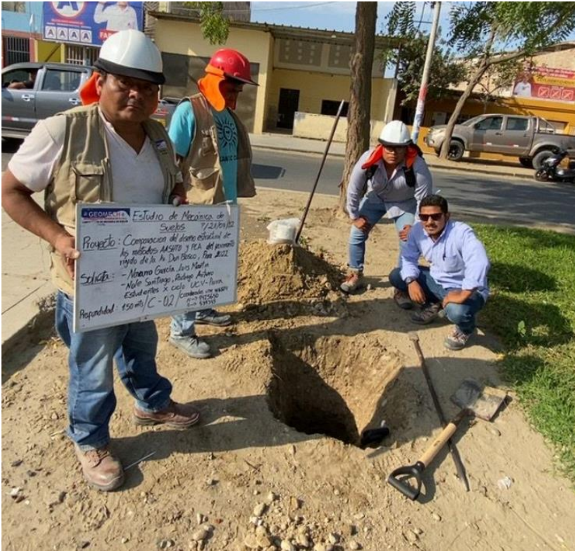
CALICATA N°02 (539345E 9425650N)
