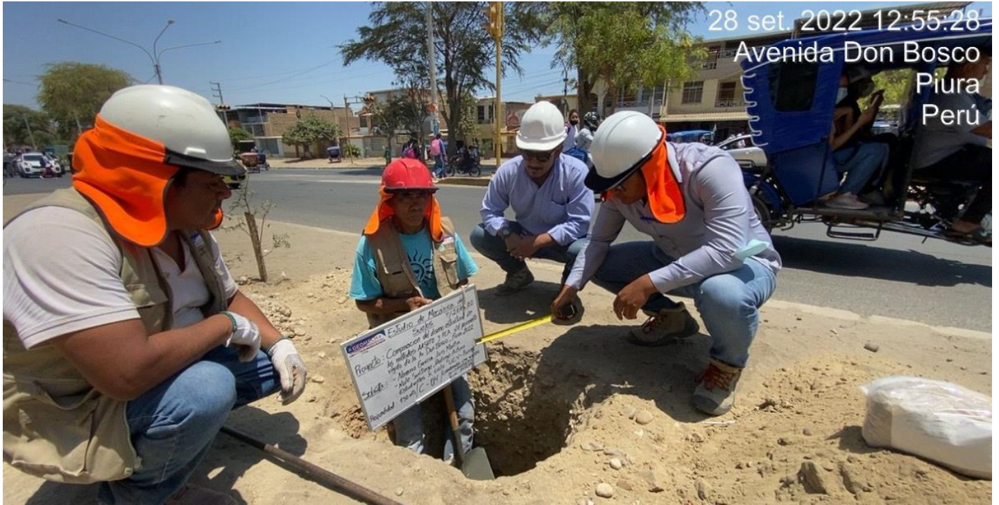
CALICATA N°04 (540278E 9425234N)
