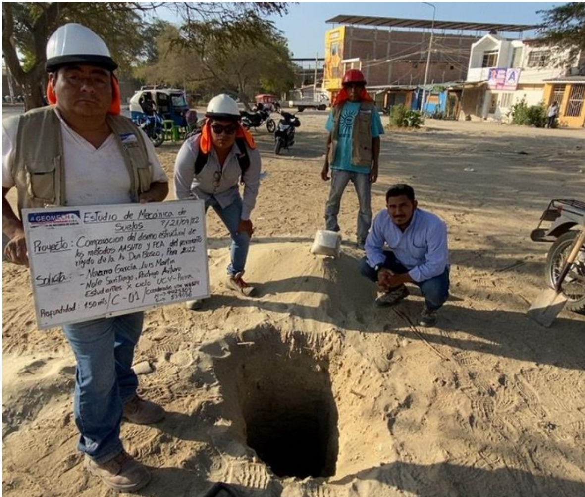
CALICATA N°01 (539056E 9425804N)
