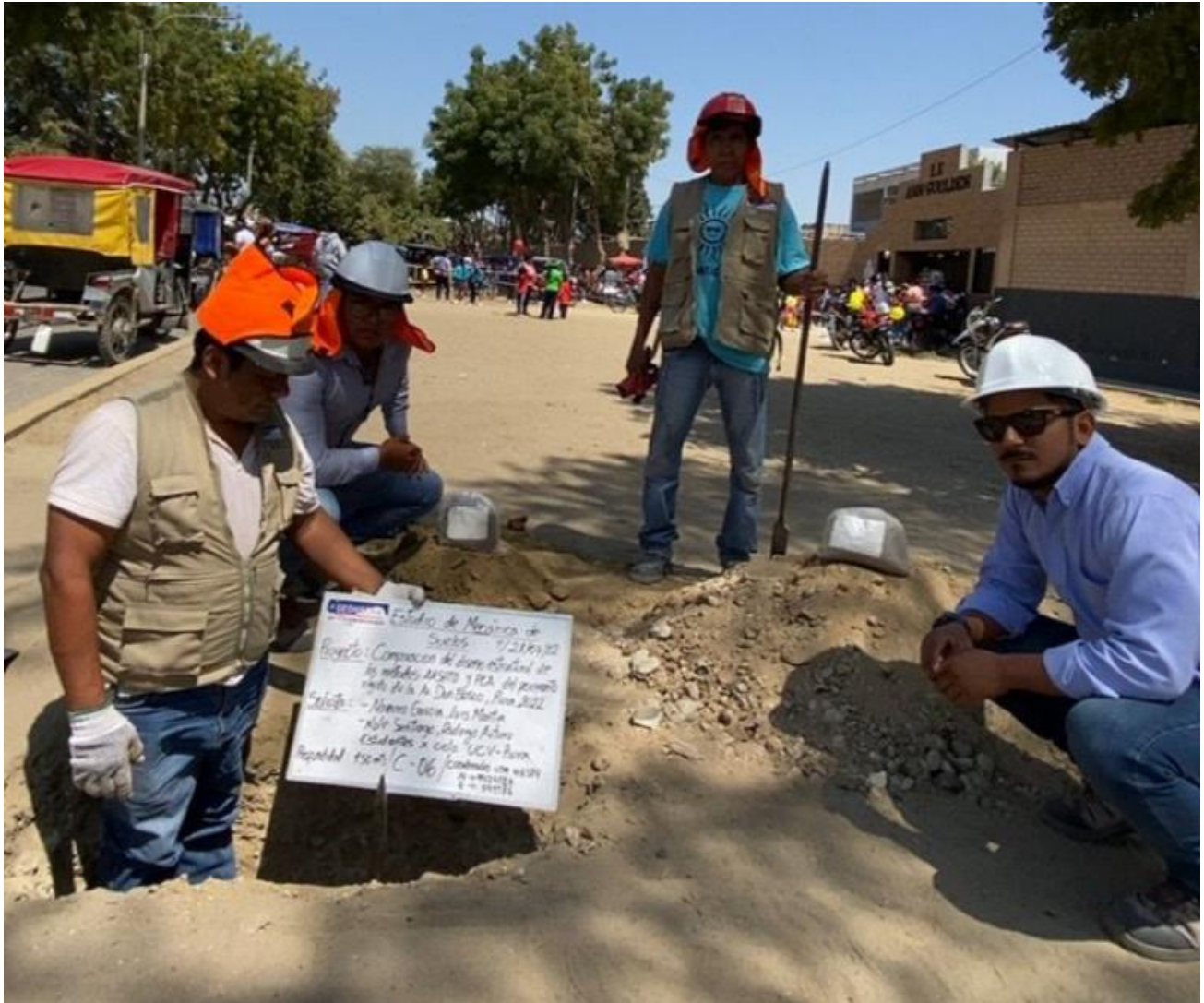
CALICATA N°06 (541186E 9424826N)
