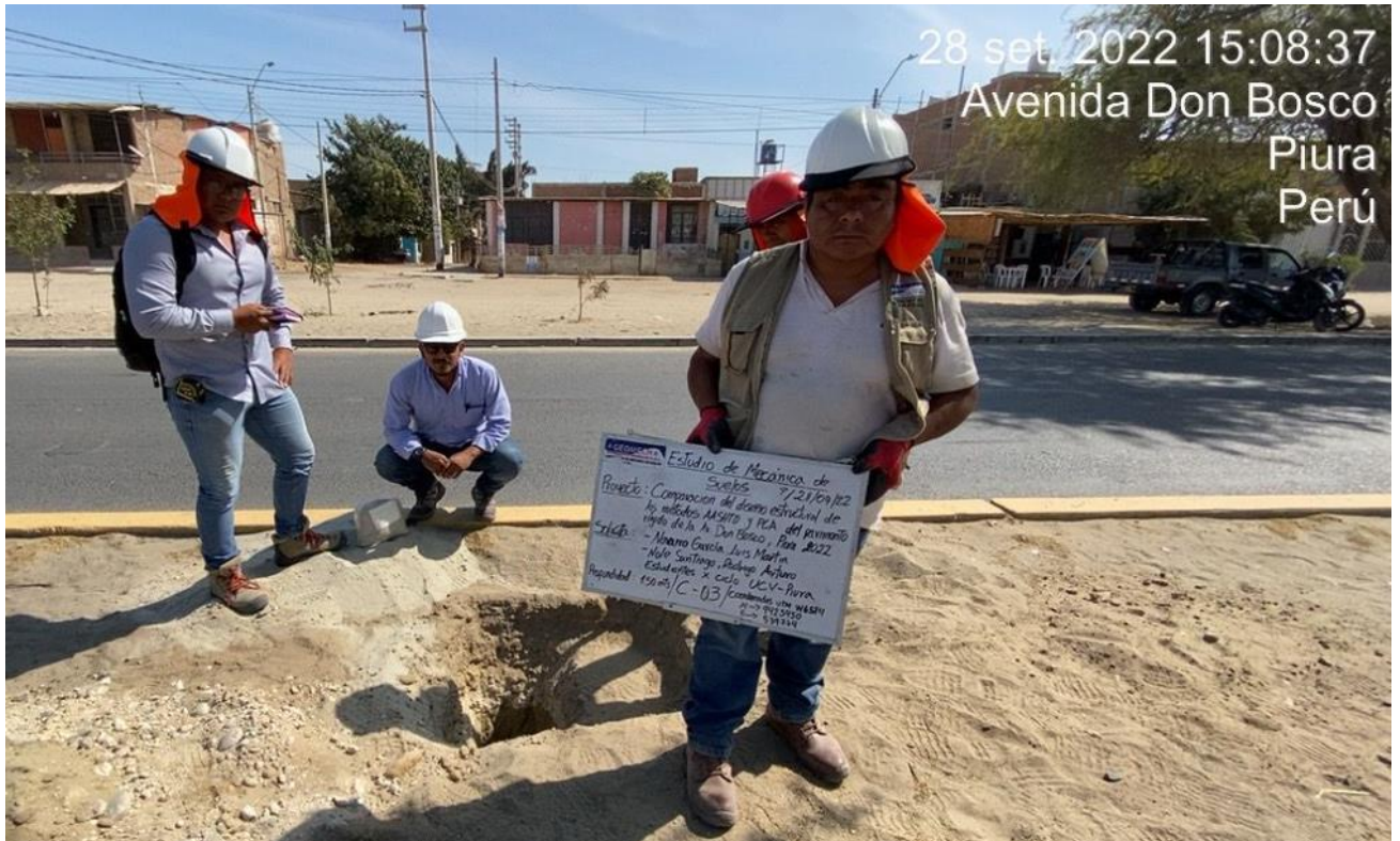
CALICATA N°03 (539774E 9425450N)
