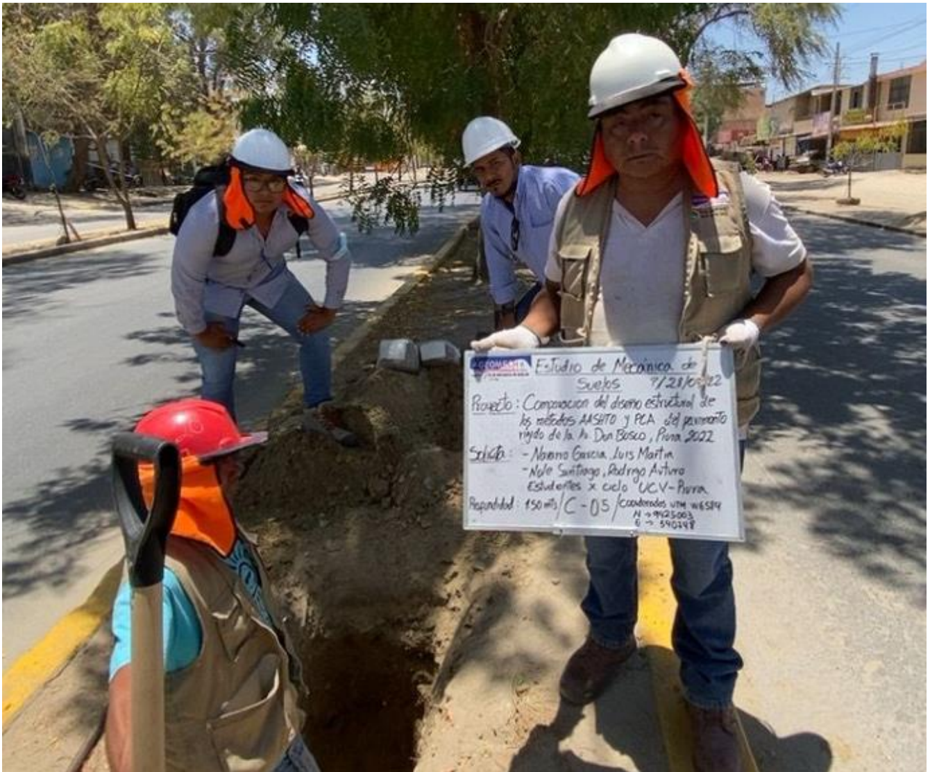
CALICATA N°05 (540748E 9425003N)
