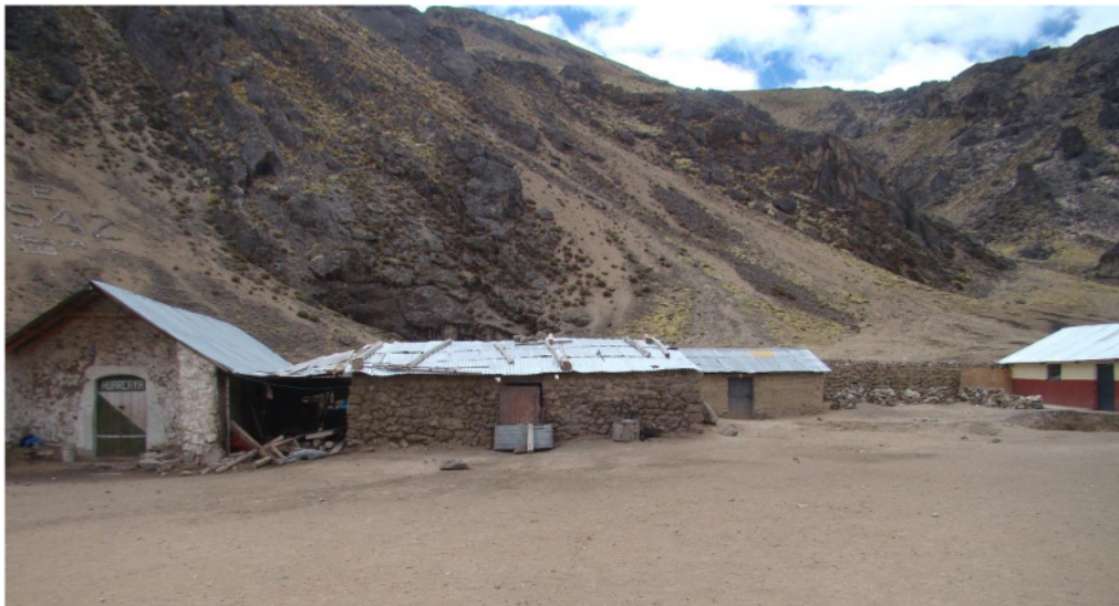
Figura 11 Condición actual del proyecto
