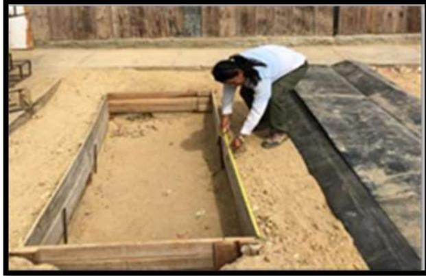
**Figura 38** Instalación de geomembrana
