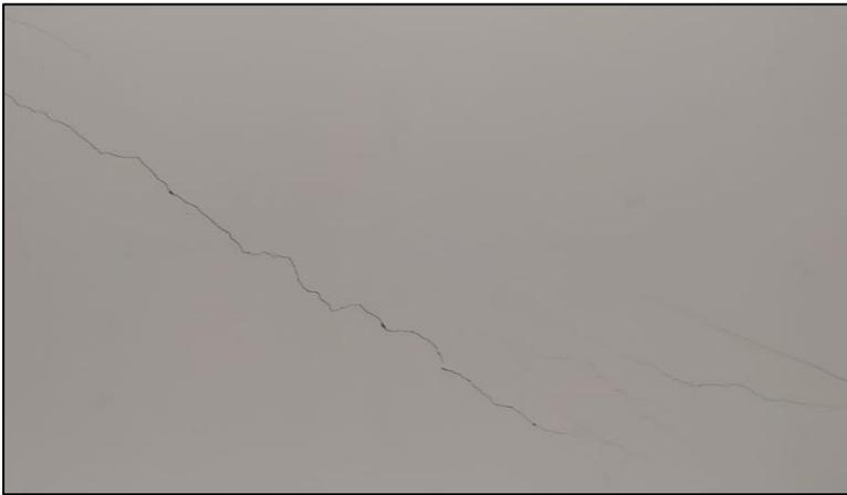
Figura 49. Primera vivienda lesiones mecánicas – fisuras.
