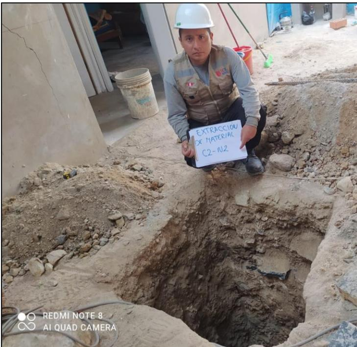
*Figura 28. Excavación de la calicata N°2.*
