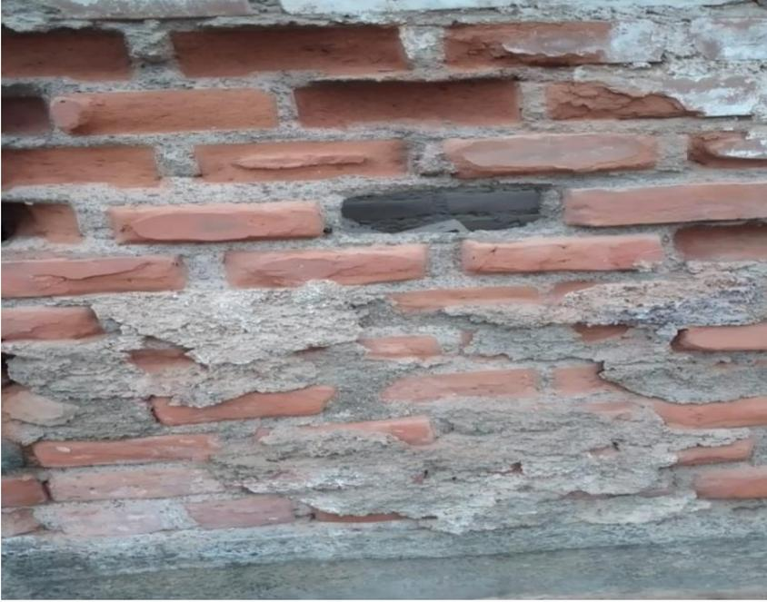
*Figura 51. Segunda vivienda lesiones físicas – erosión.*
