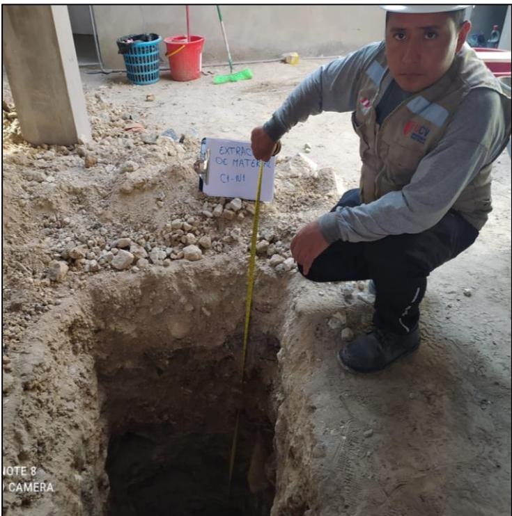
Figura 26. Medición de profundidad de la calicata N°1.
