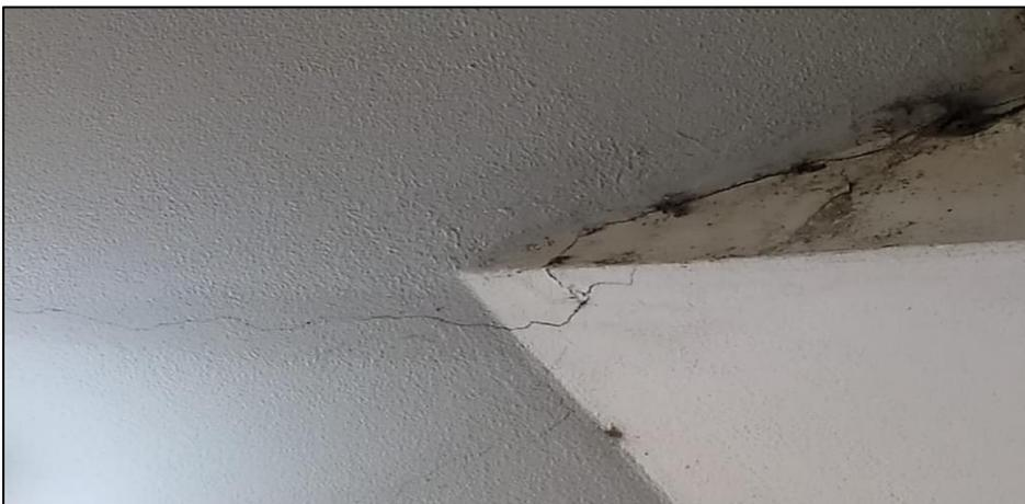
Figura 50. Primera vivienda lesiones mecánicas – fisuras.
