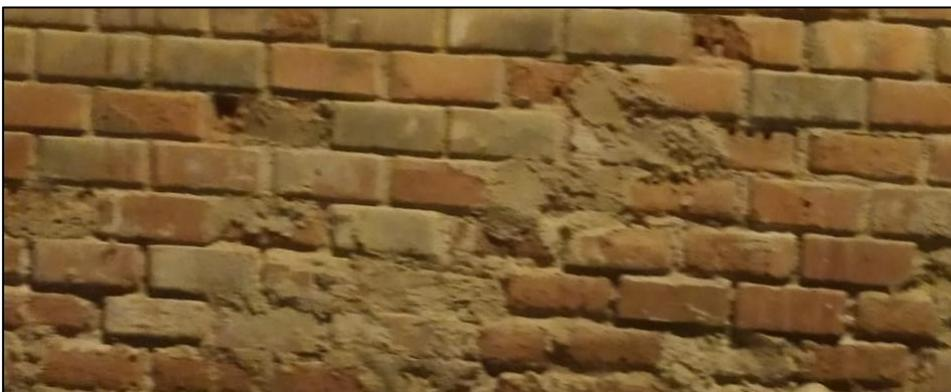
*Figura 47.* Primera vivienda lesiones físicas – erosión.
