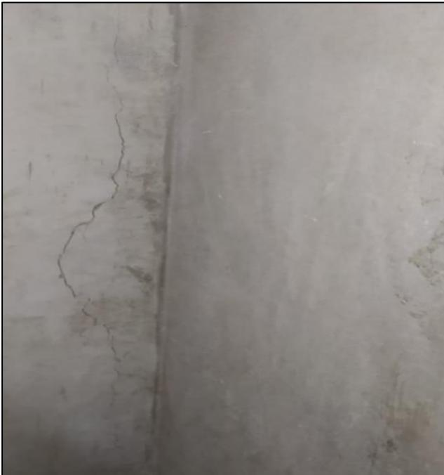
*Figura 54. Segunda vivienda lesiones mecánicas – fisuras.*
