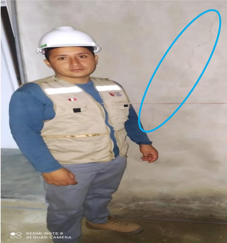
*Figura 53. Segunda vivienda lesiones mecánicas – fisuras.*
