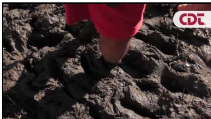
Figura 3. Mezclado de la tierra Fuente: Corporación de desarrollo tecnológico
