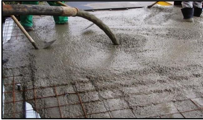
*Figura 6. Concreto autocompactante*
