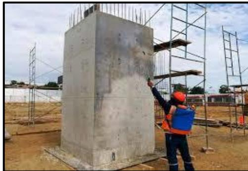
*Figura 9. Curado del concreto autocompactante*
