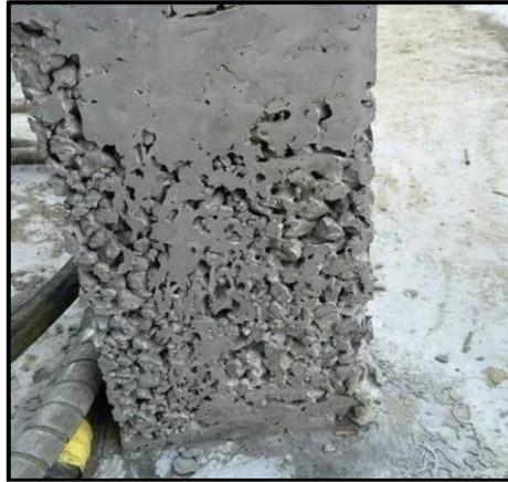
*Figura 3. Segregación del concreto.*
