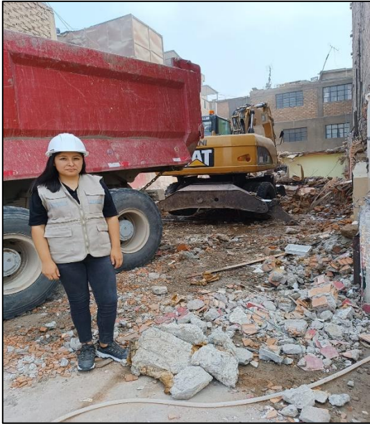
Obra en demolición en el distrito de los Olivos
