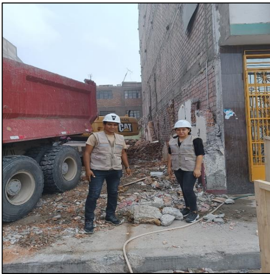
Figura 14. Obra en demolición
