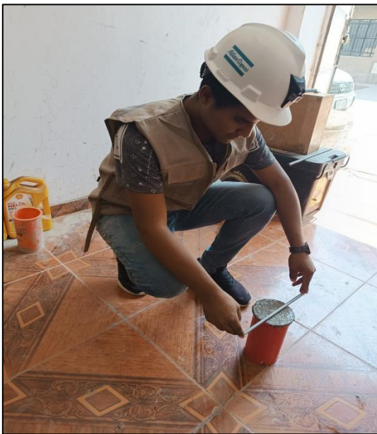
Nivelación con la varilla lisa
