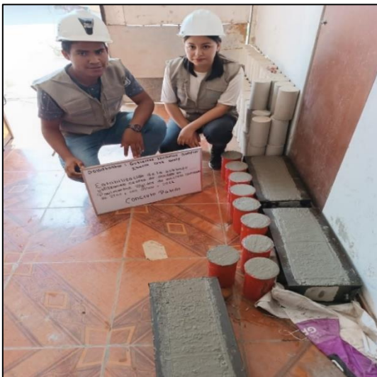
Figura 24. Probetas y vigas
