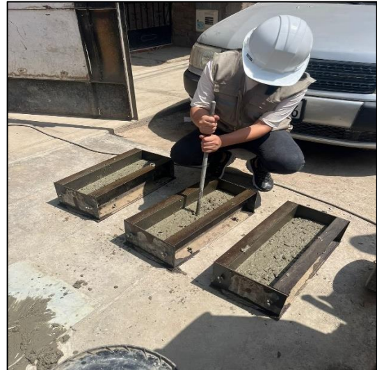
Figura 22. Chuseadas de vigas
