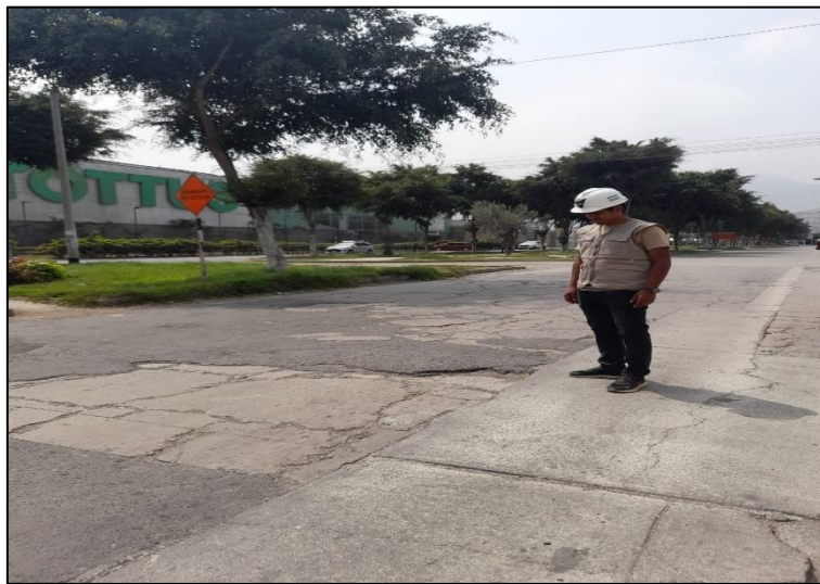
Figura 9. Revisión de la Av. Zinc
