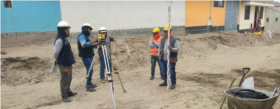
Figura 8. Equipo topográfico en trazo y replanteo para nivel de subrazante
