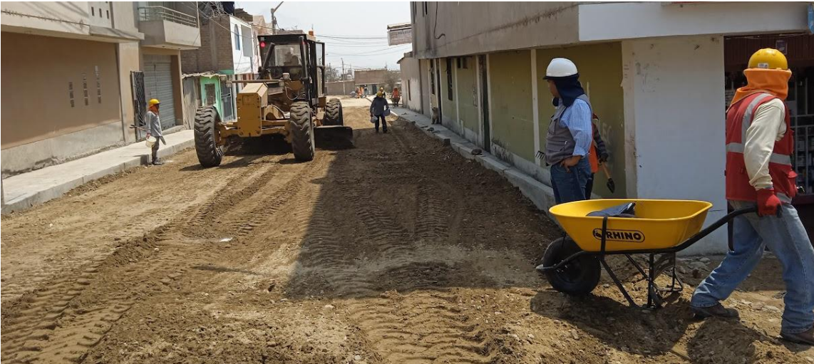
Figura 7. La toma muestra el perfilado con motoniveladora de la sub rasante del proyecto
