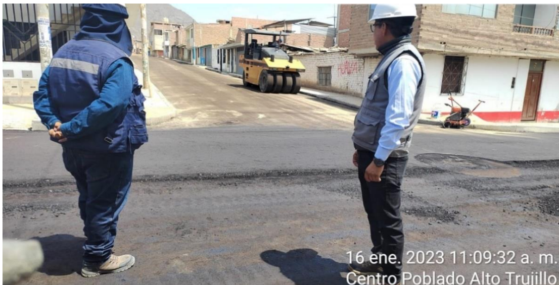
Figura 9. Compactación de la carpeta asfáltica con rodillo neumático.
