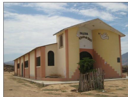
13 - IGLESIA ZONA ESTE
