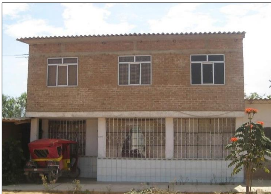
Ilustración 37: Vivienda de ladrillo de la zona
