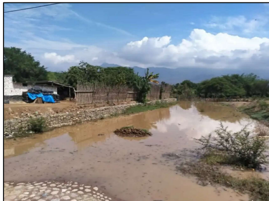
05 - VISTA DE ACEQUIA NATURAL EN ACTIVIDAD
