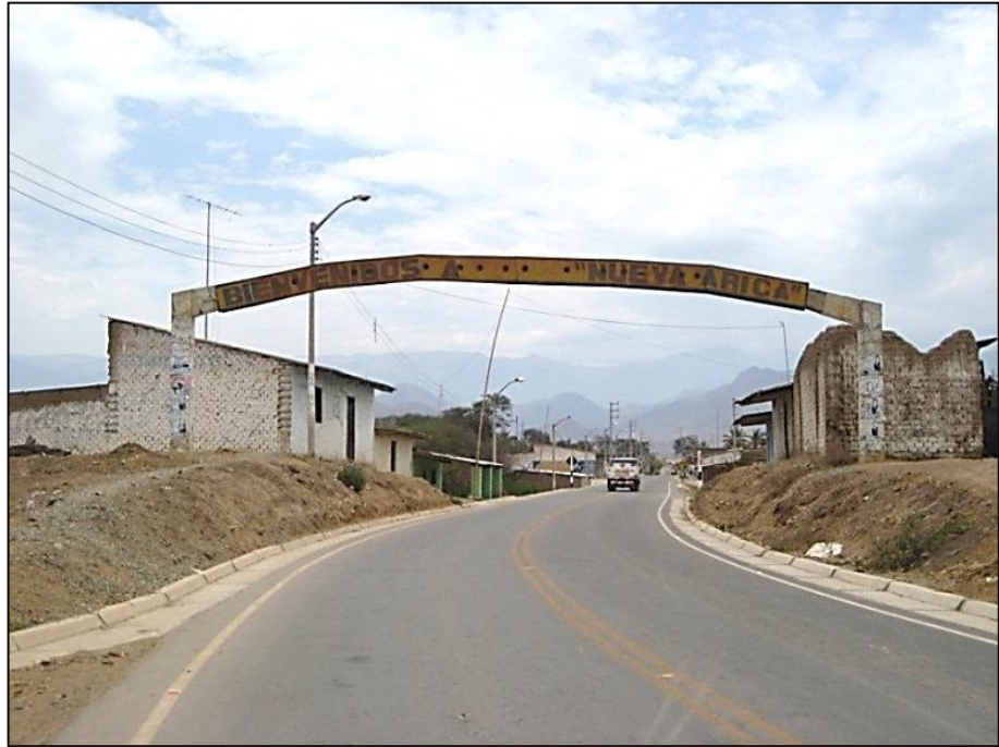
Ilustración 42: Ingreso 01 Arco de ingreso al distrito de Nueva Arica Carretera Chiclayo Oyotún Fotografía tomada por autores
