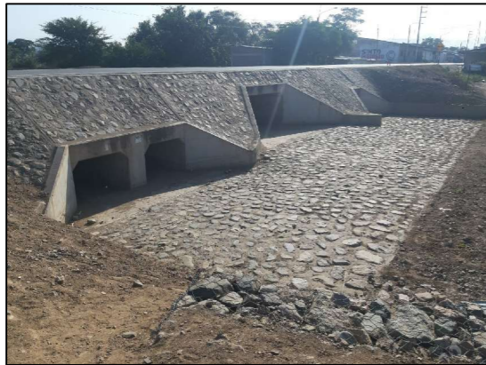
03 - VISTA DE DESEMBOCADURA DE ACEQUIA NATURAL
