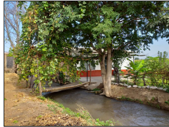
02 - VISTA DE ACEQUIA SIN CANALIZAR
