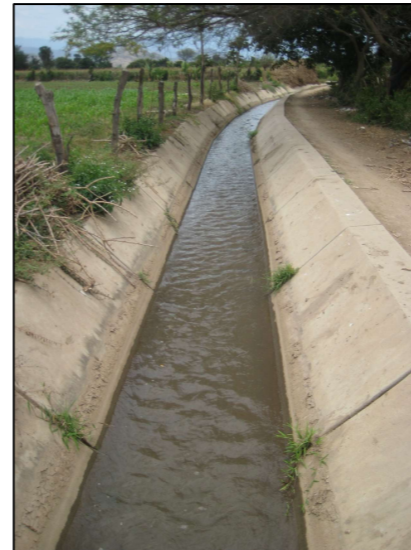
10 - VISTA DE ACEQUIA CANALIZADA
