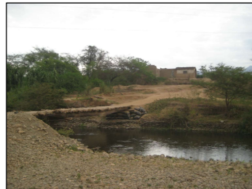
08 - VISTA DE ACEQUIA NATURA QUE SIRVE COMO EVACUACIÓN DE AGUAS PLUVIALES
