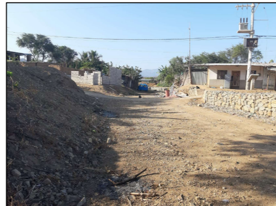
06 - VISTA DE ACEQUIA NATURAL EN INACTIVIDAD
