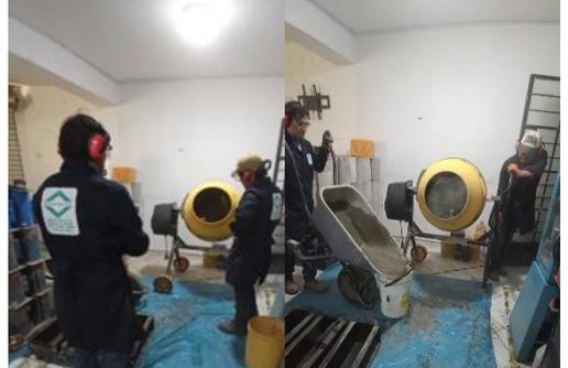
**Fotografía 18:** Realizando la mezcla del concreto con una mezcladora mediana
