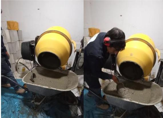
**Fotografía 19:** Mezcla del concreto preparada
