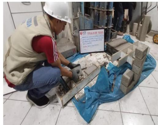
**Fotografía 22:** Realizando el desencofrado de los adoquines de concreto
